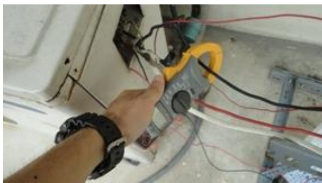
รูปที่ 4.11 แสดงการวัดกระแสไฟฟ้าที่คอนเดนซิ่งยูนิต
