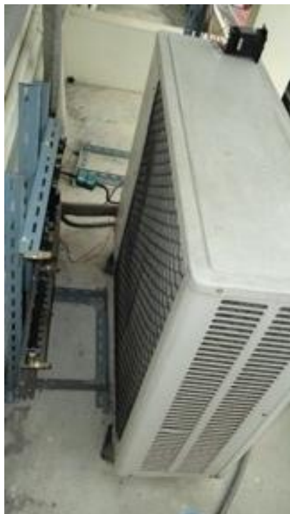
รูปที่ 4.10 คอนเดนซิ่งยูนิตที่ทำการทดสอบสมรรถนะ
