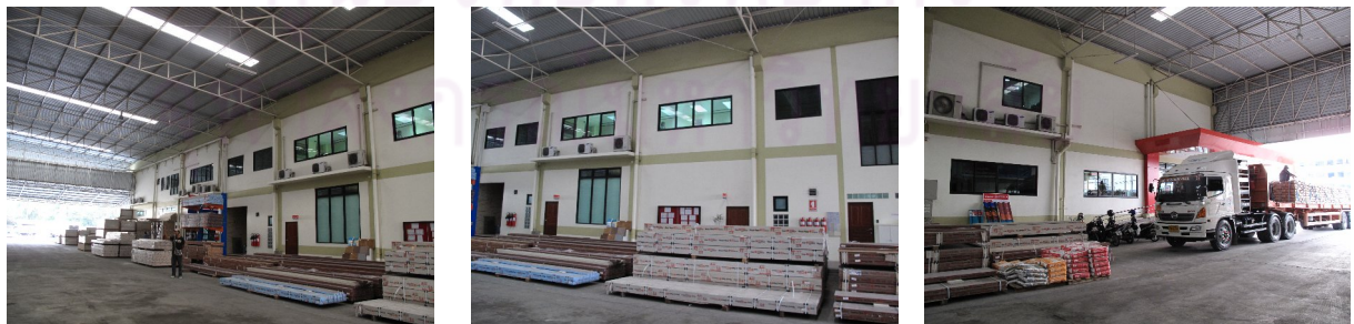
รูปภาพที่ 4.7 แสดงรูปด้านข้างซ้ายของอาคารกรณีศึกษาร้านโฮมมาร์ท สمارทโฮมโปรดักส์ ทิศ ตะวันออกเฉียงใต้ ติดกับอาคารพาณิชย์ขนาดใหญ่ 2 ชั้น
