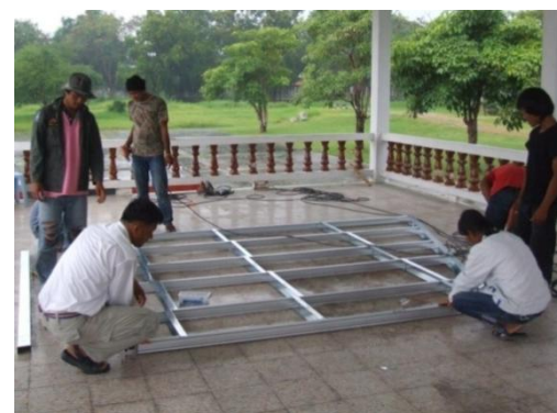
ภาพที่ 4.19 การประกอบโครงผนังที่ไม่มีช่องเปิดของอาคารเรียนต้นแบบ
