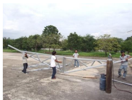
ภาพที่ 4.23 การประกอบ และติดตั้งโครงสร้างหลังคา ของอาคารเรียนต้นแบบ
