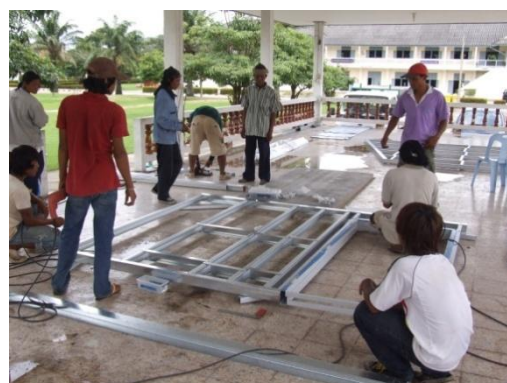
ภาพที่ 4.21 การประกอบโครงผนังที่มีประตูของอาคารเรียนต้นแบบ
