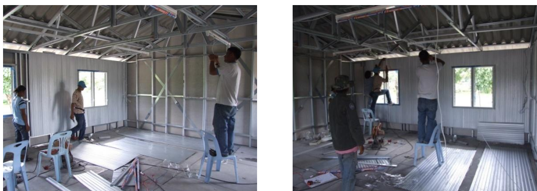
ภาพที่ 4.27 การติดตั้งงานระบบและเก็บรายละเอียดของอาคารเรียนต้นแบบ
