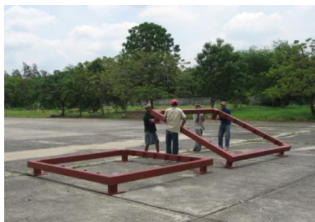
ภาพที่ 4.17 การติดตั้งโครงสร้างพื้นและตงของอาคารเรียนต้นแบบ
