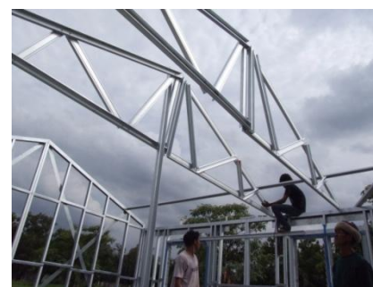
ภาพที่ 4.23 การประกอบ และติดตั้งโครงสร้างหลังคา ของอาคารเรียนต้นแบบ
