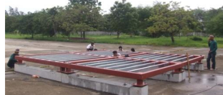
ภาพที่ 4.17 การติดตั้งโครงสร้างพื้นและตงของอาคารเรียนต้นแบบ (ต่อ)
