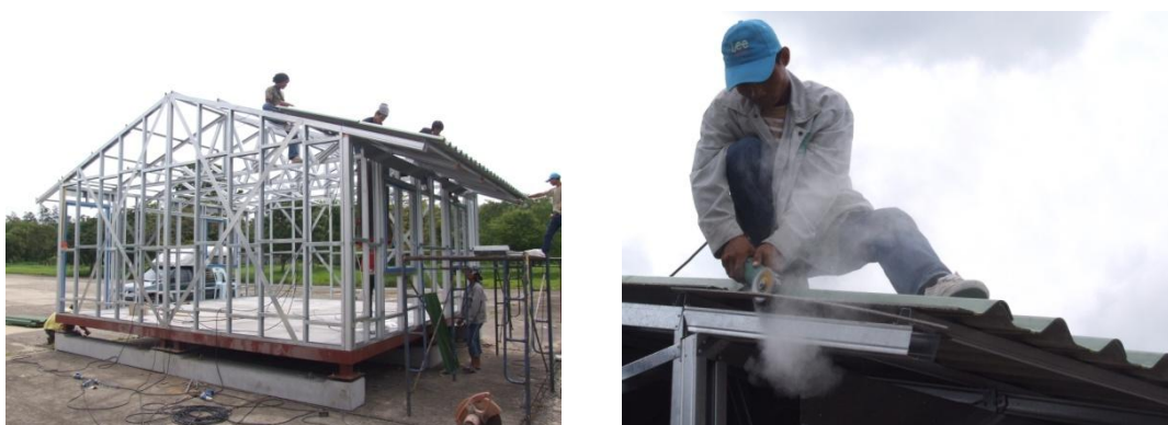
ภาพที่ 4.24 การกรูวัสดุหลังคาของอาคารเรียนต้นแบบ
