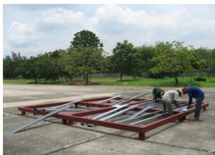
ภาพที่ 4.17 การติดตั้งโครงสร้างพื้นและตงของอาคารเรียนต้นแบบ (ต่อ)
