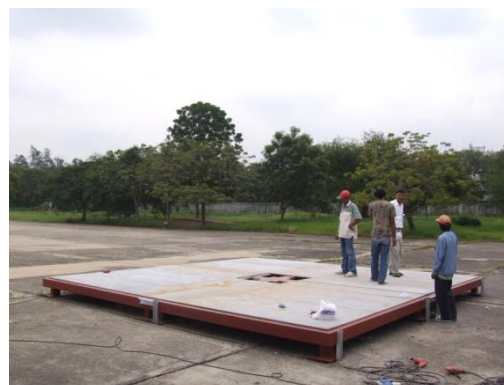
ภาพที่ 4.18 การติดตั้งแผ่นพื้นของอาคารเรียนต้นแบบ
