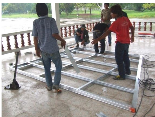
ภาพที่ 4.19 การประกอบโครงผนังที่ไม่มีช่องเปิดของอาคารเรียนต้นแบบ
