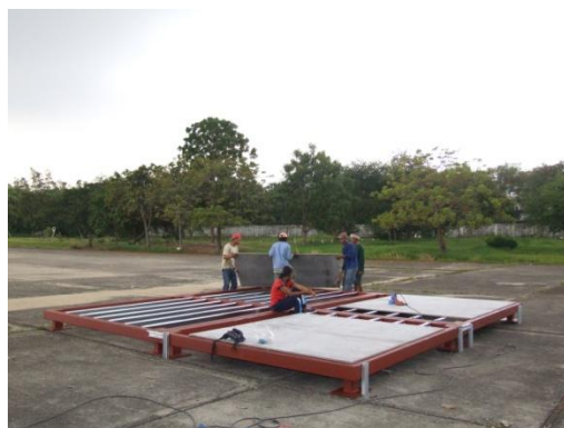
ภาพที่ 4.18 การติดตั้งแผ่นพื้นของอาคารเรียนต้นแบบ
