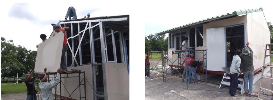
ภาพที่ 4.25 การกรูวัสดุผนังภายนอกของอาคารเรียนต้นแบบ
