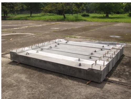
ภาพที่ 4.16 การติดตั้งฐานอาคารของอาคารเรียนต้นแบบ
