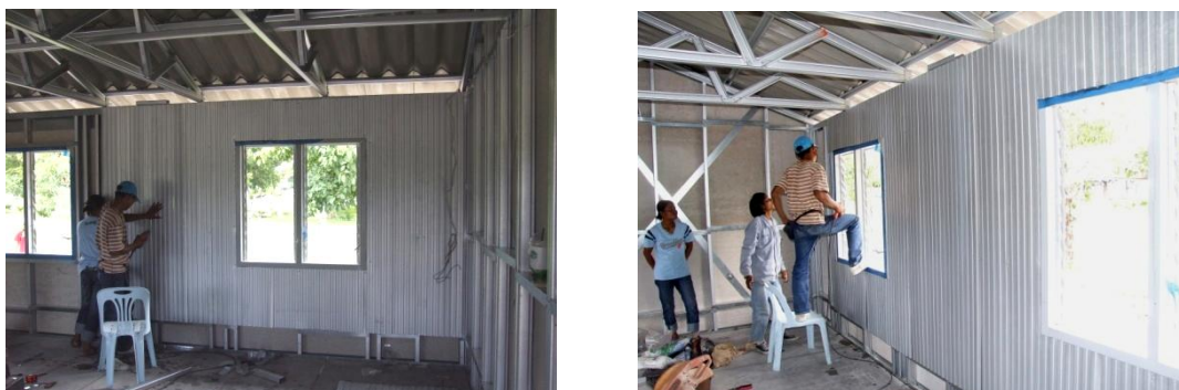
ภาพที่ 4.26 การกรูวัสดุผนังภายในของอาคารเรียนต้นแบบ
