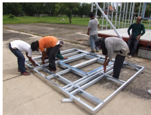
ภาพที่ 4.20 การประกอบโครงผนังที่มีช่องเปิดของอาคารเรียนต้นแบบ
