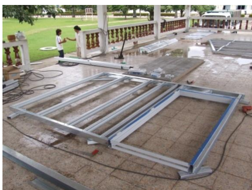
ภาพที่ 4.21 การประกอบโครงผนังที่มีประตูของอาคารเรียนต้นแบบ
