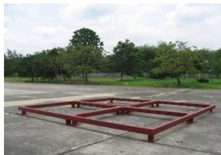
ภาพที่ 4.17 การติดตั้งโครงสร้างพื้นและตงของอาคารเรียนต้นแบบ
