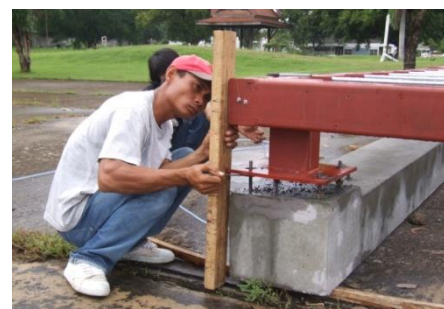
ภาพที่ 4.17 การติดตั้งโครงสร้างพื้นและตงของอาคารเรียนต้นแบบ (ต่อ)
