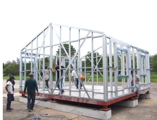
ภาพที่ 4.22 การติดตั้งโครงสร้างผนังของอาคารเรียนต้นแบบ
