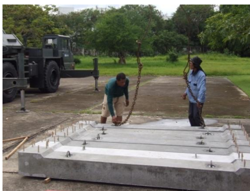
ภาพที่ 4.16 การติดตั้งฐานอาคารของอาคารเรียนต้นแบบ (ต่อ)
