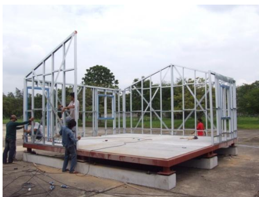
ภาพที่ 4.22 การติดตั้งโครงสร้างผนังของอาคารเรียนต้นแบบ
