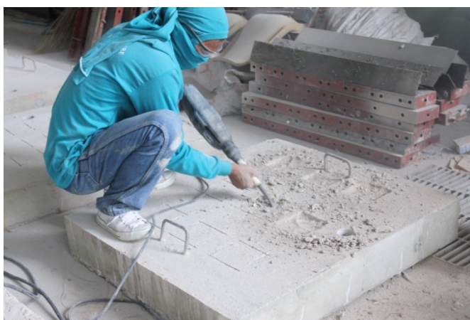
ภาพที่ 28 การใช้สว่านสกัดผิวให้ได้ความลึกใกล้เคียงกับที่ต้องการ
