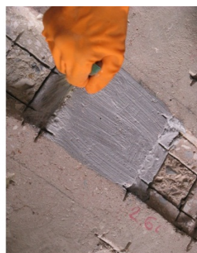
b) ทาน้ำยาประสานระหว่างผิวคอนกรีตเดิมและวัสดุซ่อม
