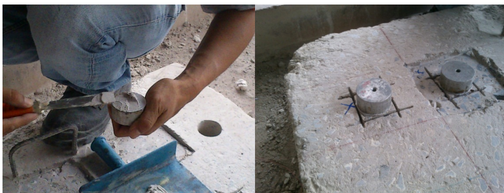
ภาพที่ 31 การติดตั้งลูกเหล็ก
