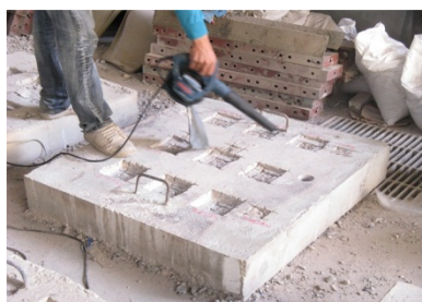
a) เป่าทำความสะอาดผิวที่จะซ่อม
