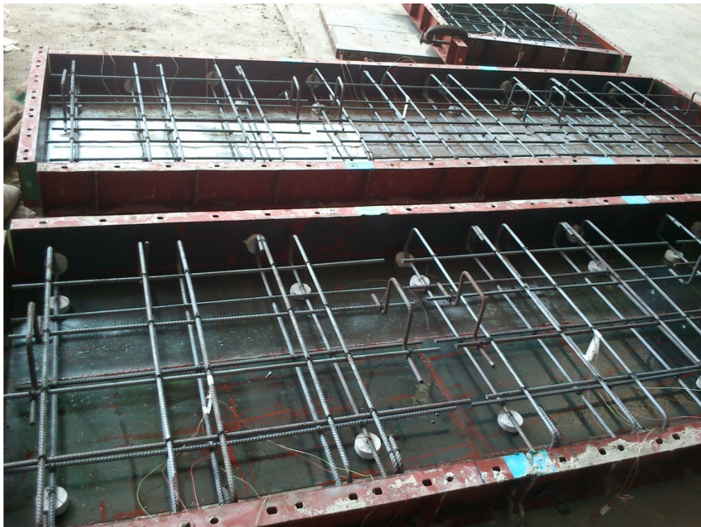
ภาพที่ 10 การตั้งแบบหล่อขึ้นตัวอย่าง
