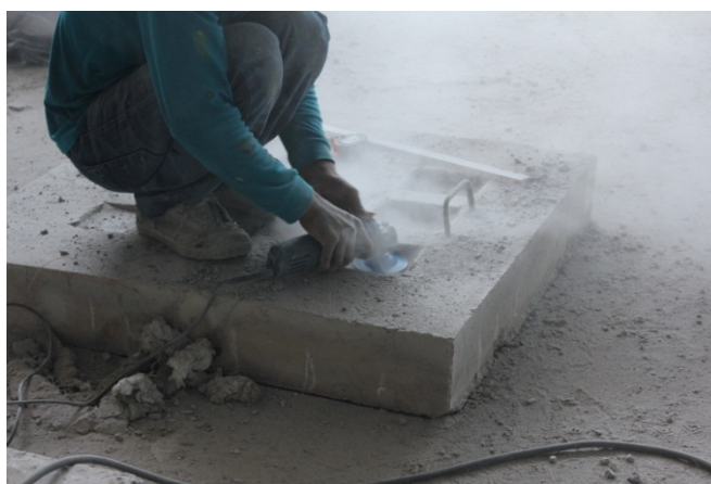
ภาพที่ 29 การใช้เครื่องเจียร เจียรให้เรียบและให้ได้ความลึกที่ต้องการ
