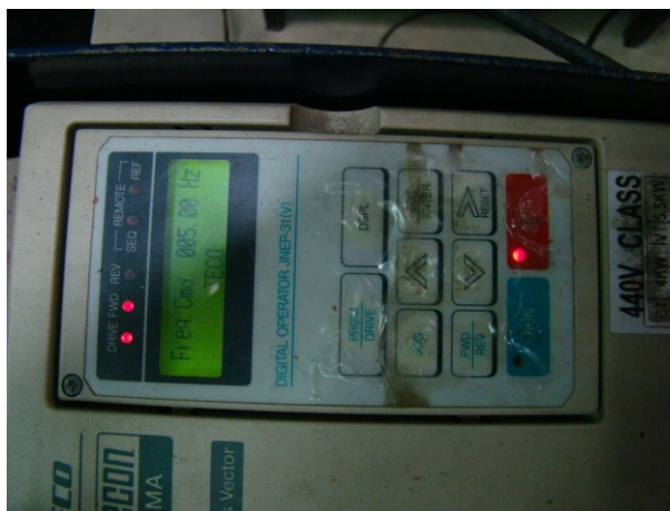
ภาพที่ ค.15 ปรับเปลี่ยนความเร็วรอบโดยอินเวอร์เตอร์ที่ใช้ควบคุมความถี่ของมอเตอร์ตัวขับเคลื่อน
