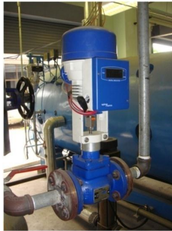
ภาพที่ 4.18 วาล์วควบคุม
