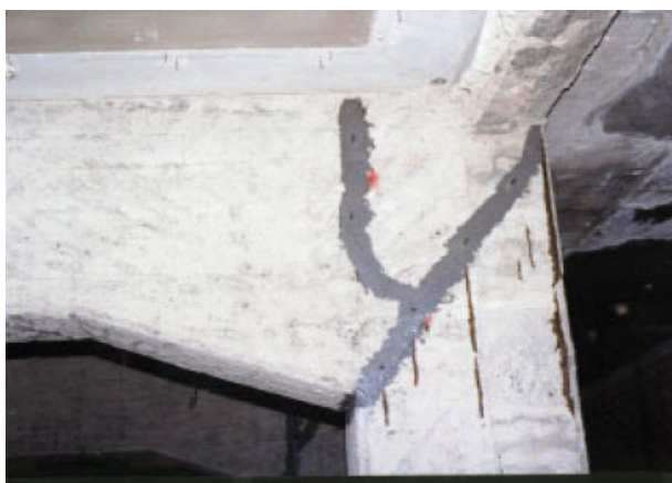
รูปที่ 2.35 การซ่อมแซมรอยร้าวด้วยคอนกรีต (cement grout)
