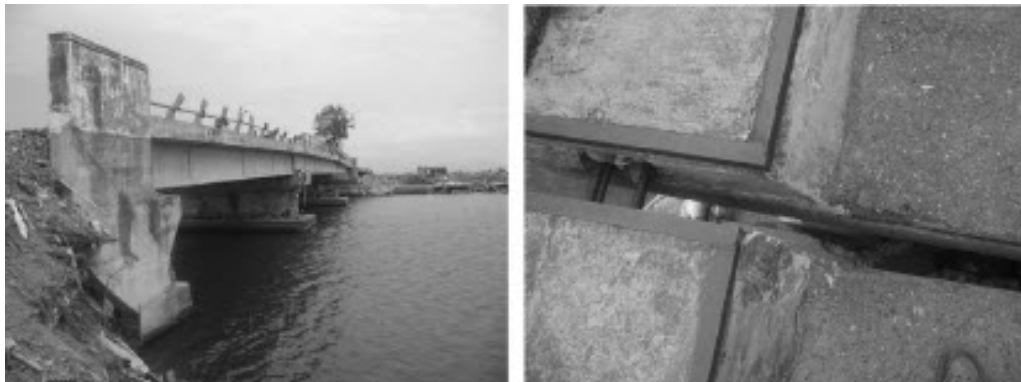
รูปที่ 2.12 สะพานที่ Banda Aceh และรอยแยกตัวออกจากกันของสะพาน (Saatcioglu และคณะ, 2006)
