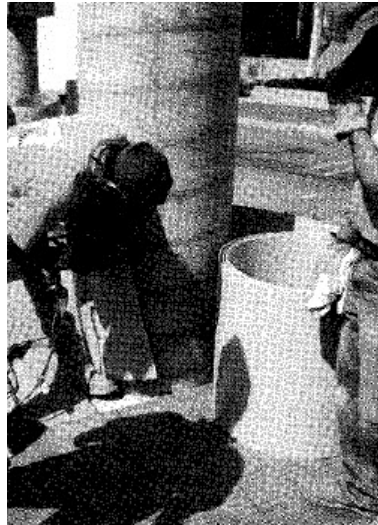
รูปที่ 2.22 การซ่อมแซมเสาด้วยการติดตั้งแผ่นเสริมกำลังแบบ continuous shell
