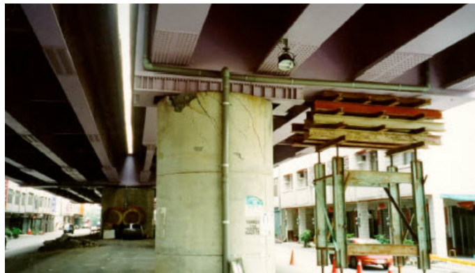
รูปที่ 2.11 ความเสียหายของสะพาน Mao Lou Shi (Christopoulos และคณะ, 2002)
