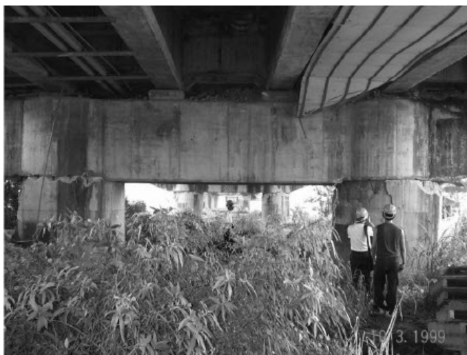
รูปที่ 2.8 ความเสียหายจากการเคลื่อนที่ของเสาที่มากเกินไป ของสะพาน Yen Feng (Christopoulos และคณะ, 2002)
