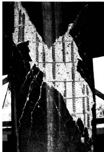
รูปที่ 2.5 ความเสียหายที่เกิดจากแรงเฉือนในเสาเนื่องจากแรงแผ่นดินไหว (Priestley และคณะ, 1988)
