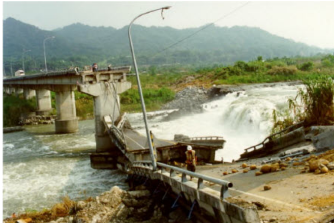
รูปที่ 2.6 ความเสียหายแบบ span collapse ของสะพาน Pei Feng (Christopoulos และคณะ, 2002)
