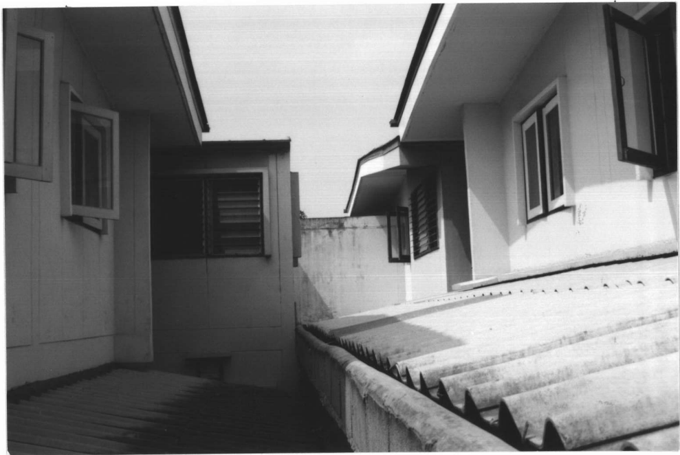
รูปที่ 11 ด้านหลังของบ้านเดี่ยว มีการต่อเติมเพื่อใช้เป็นครัว จนทำให้ไม่เหลือที่ว่างด้าน หลังอาคาร 2.00 เมตร เช่นเดียวกัน
