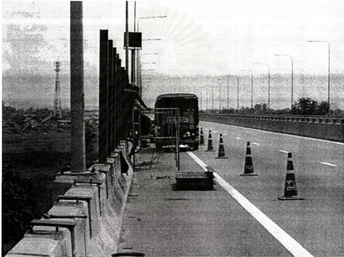
รูปที่ 7.9 การติดตั้งเสา H-Beam เพื่อใช้ในการยึดแผงกันเสียงบริเวณริมทางด่วน
