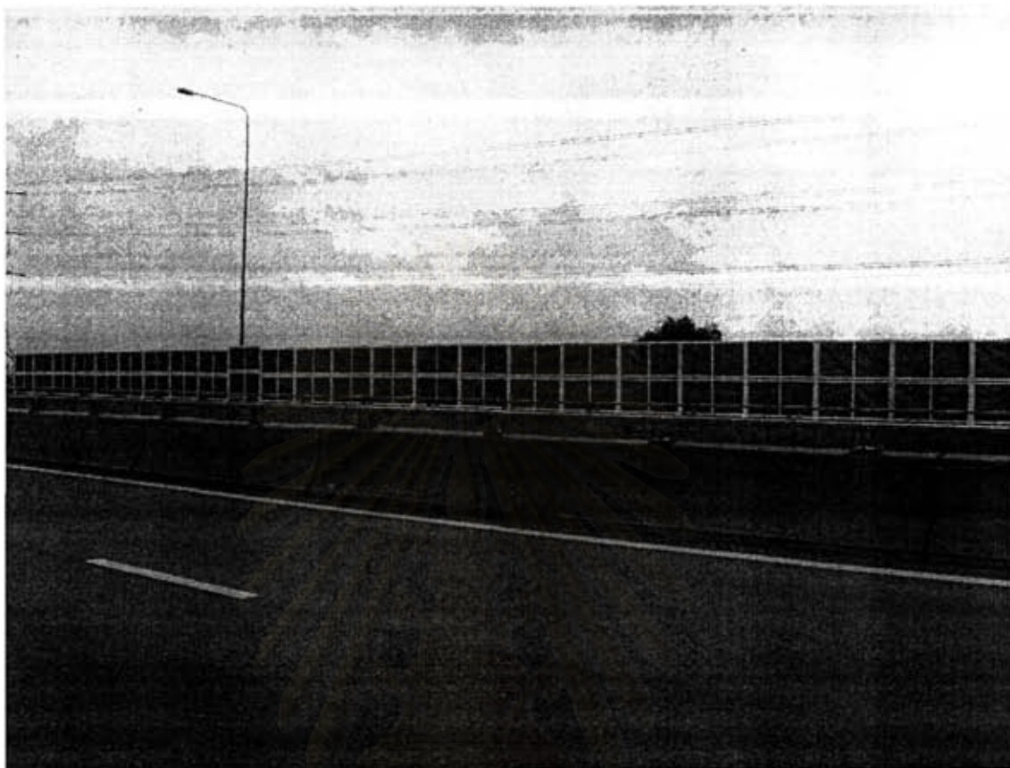
รูปที่ 7.13 แนวของแผงกันเสียงหลังจากการติดตั้งแผงกันเสียงแล้วเสร็จ
