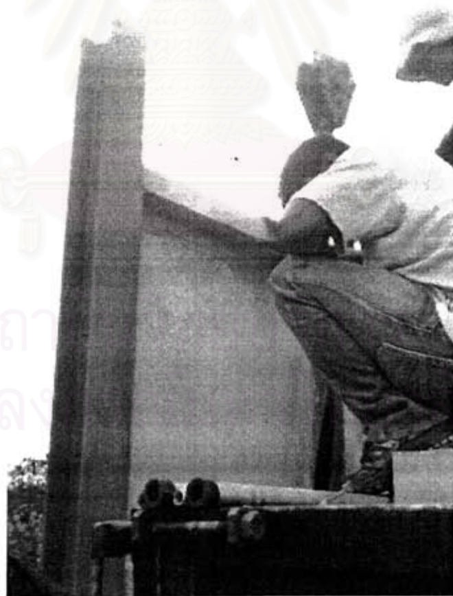
รูปที่ 7.11 การติดตั้งแผงกันเสียงโดยใช้เครนยกขึ้นสอดกับเสาเหล็ก
