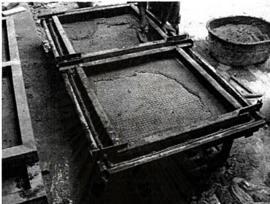
รูปที่ 6.4 การจัดวางเหล็กเสริมบนแบบหล่อ และการฉาบมอร์ตาร์บนโครงตาข่าย
