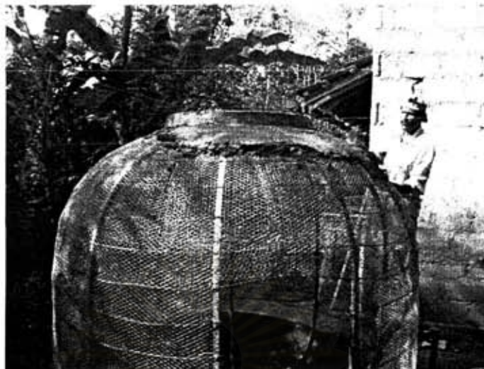
รูปที่ 5.16 การตัดโครงตาข่ายเป็นรูปทรงที่ต้องการและทำการจามมอร์ด้าริให้ยึดเกาะกับโครงตาข่ายที่ตัดให้เป็นรูปร่างที่ต้องการไว้
