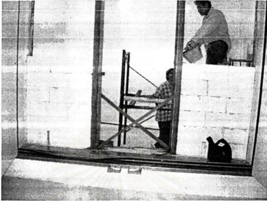
รูปที่ 6.22 การก่อผนังอิฐมวลเบาเพื่อเตรียมทดสอบ
