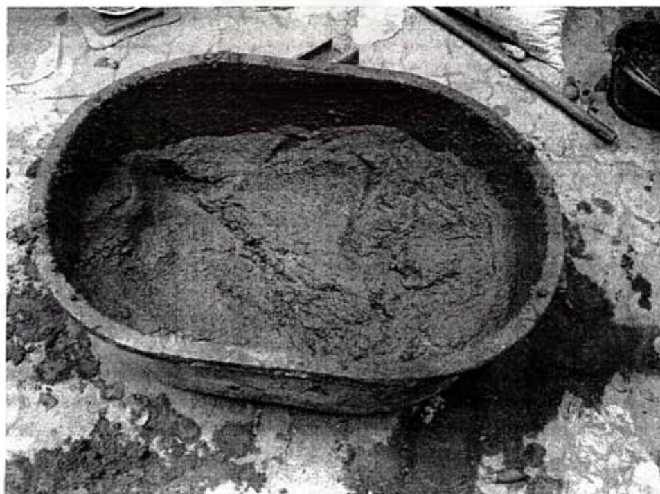
รูปที่ 6.3 การผสมมอร์ตาร์ตามอัตราส่วนที่ต้องการ
