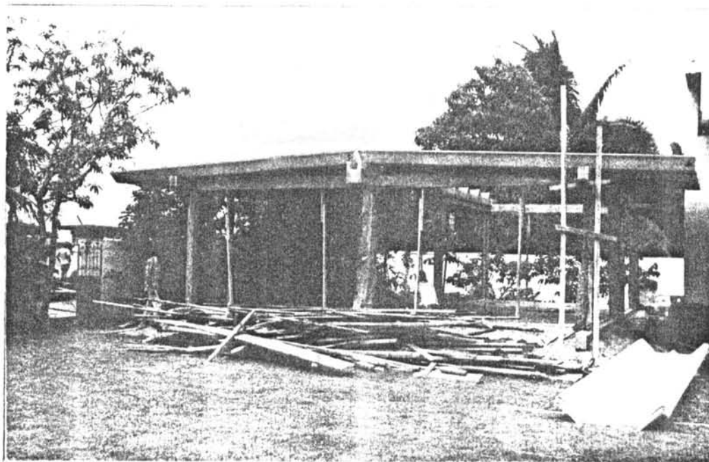
รูปที่ (45) - รูปคานหน้าเมื่อทิศตั้งหลังคาได้บางส่วน
