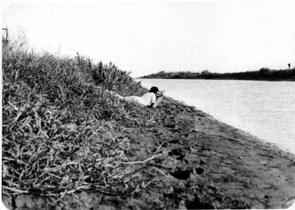
รูปที่ 4-2 แสดงการใช้กล้องระดับ วัดหาความลาดเอียงของท้องคลอง ( ค.ระบายน้ำที่ 13 )
