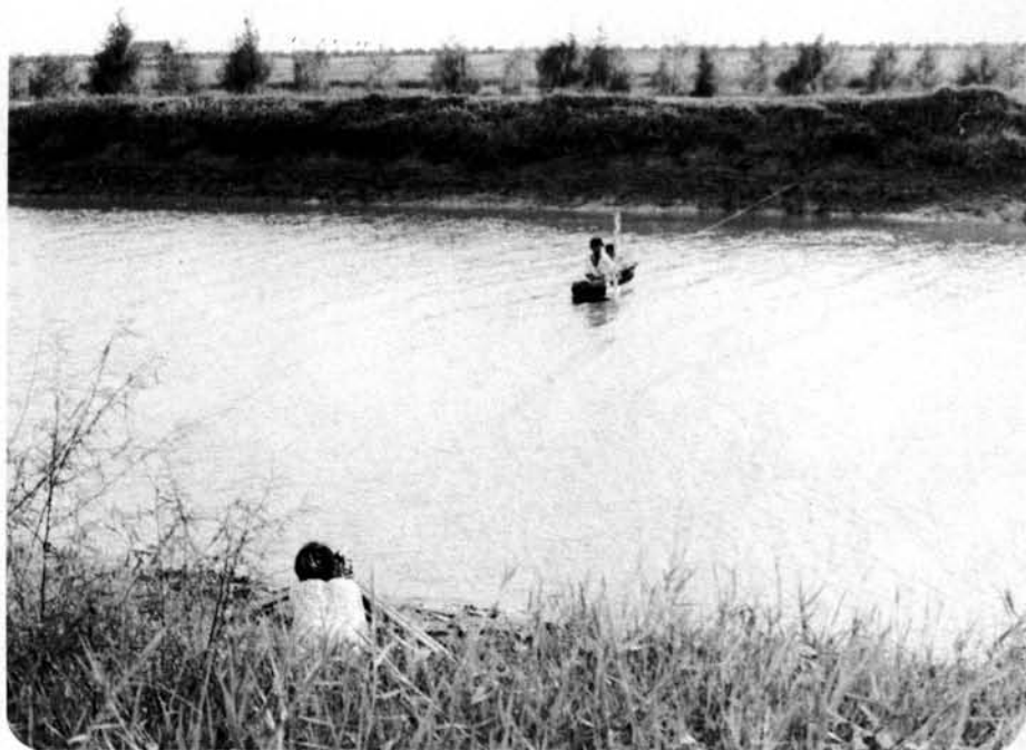
รูปที่ 4-3 แสดงการใช้กล้องระดับ วัดระดับท้องคลอง เพื่อหาความลาดเอียงท้องคลอง
