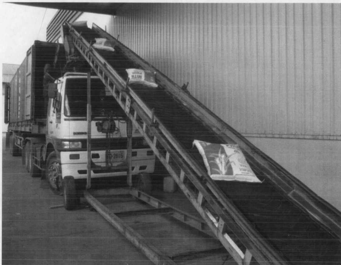
รูปที่ 4.10 การลำเลียงน้ำตาลทรายถุงด้วย Conveyor
