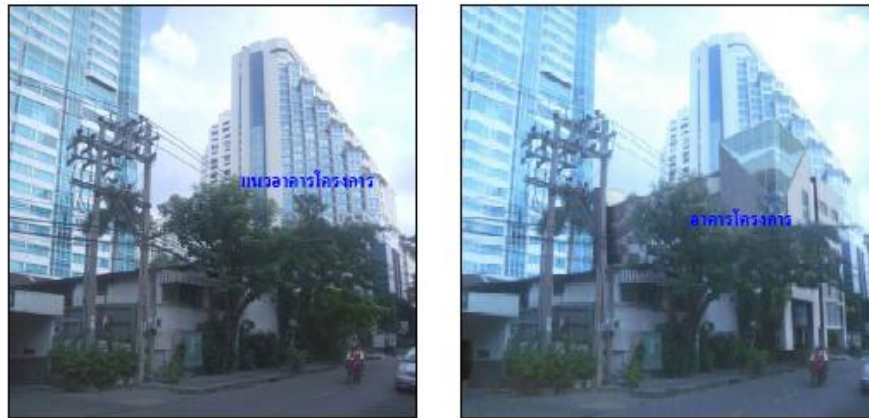
ก่อนมีโครงการ
