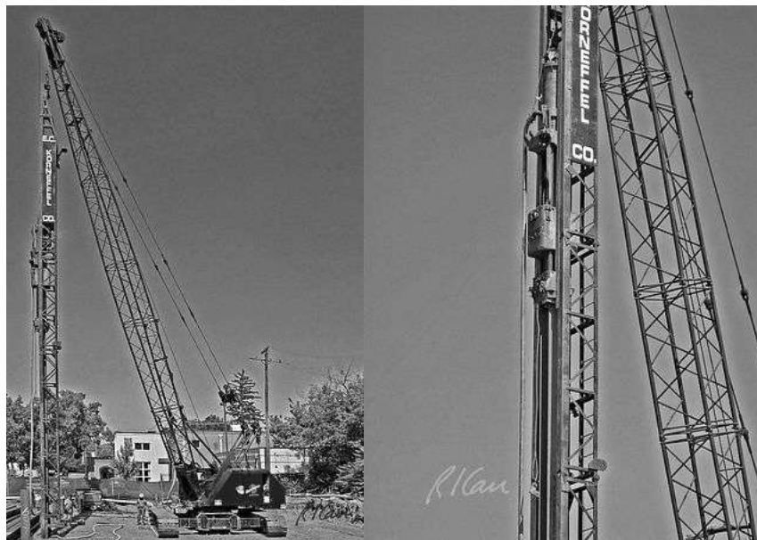
รูปที่ 2.4 การตอกเสาเข็มวิธี Steam hammer
