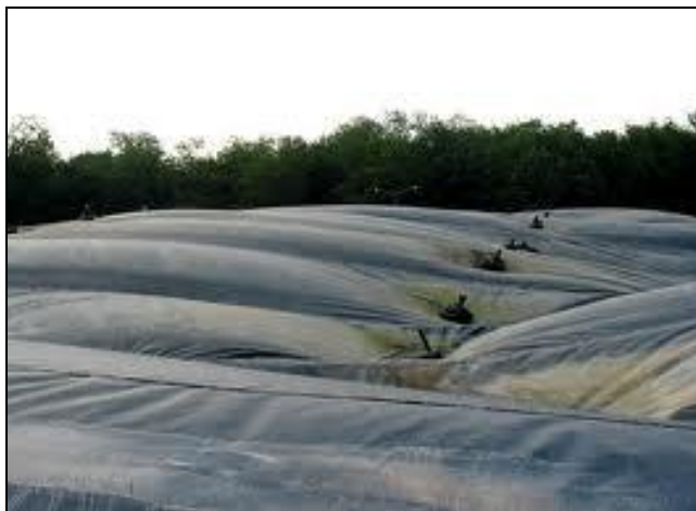
ภาพที่ 2 - 5 ระบบบ่อไร้อากาศแบบคลุมบ่อ (Cover lagoon)
