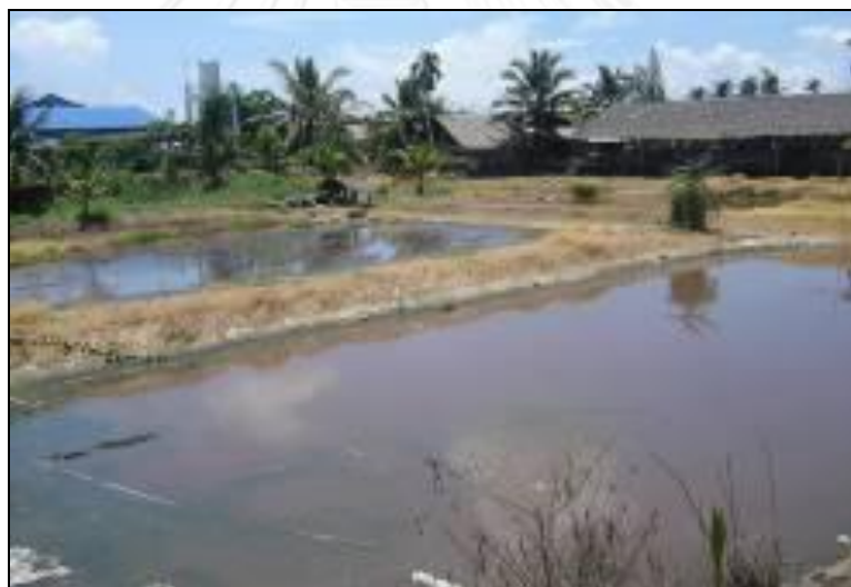
ภาพที่ 2 - 3 ระบบบำบัดน้ำเสียแบบบ่อปรับเสถียร
