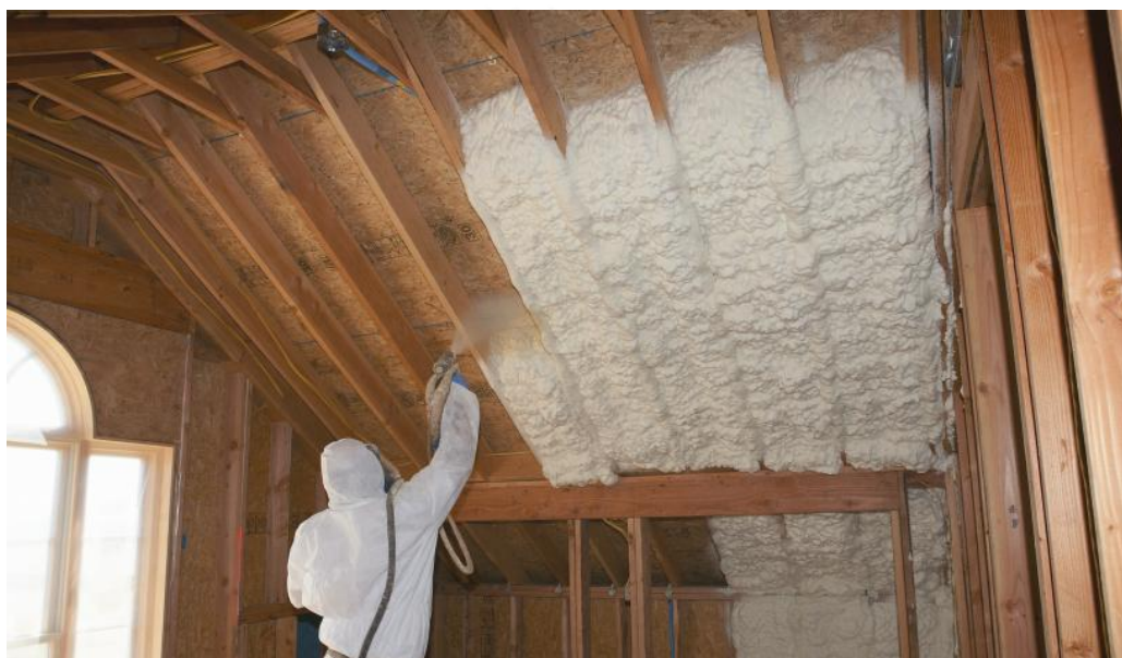
รูปที่ 2 - 2 แสดงภาพการฉีดพ่นโฟม Polyurethane บริเวณใต้หลังคา (ที่มา http://www.certainteed.com/images/products/thumbnails/aspraycathceiling2md.jpg )
