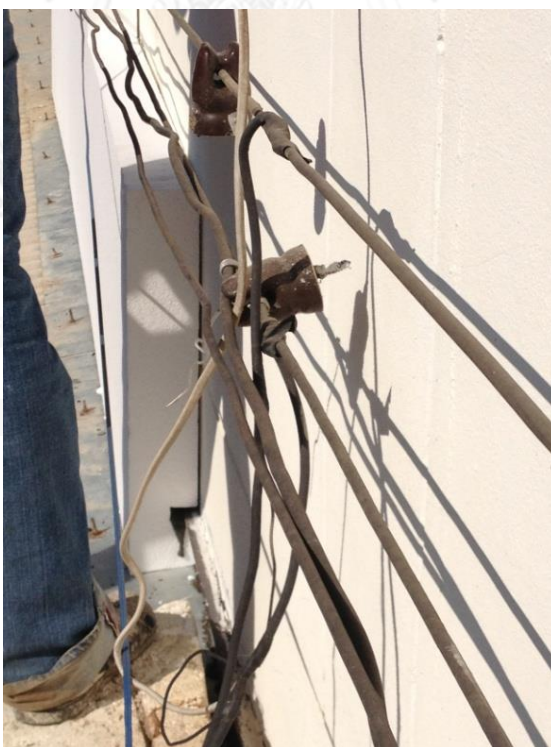
รูปที่ 4 – 25 แสดงฉนวนที่ผ่านการติดตั้งอย่างถูกวิธี โดยฉนวนแนบไปกับผิว ผนัง (บันทึกภาพวันที่ 18 ธ.ค. 55)
