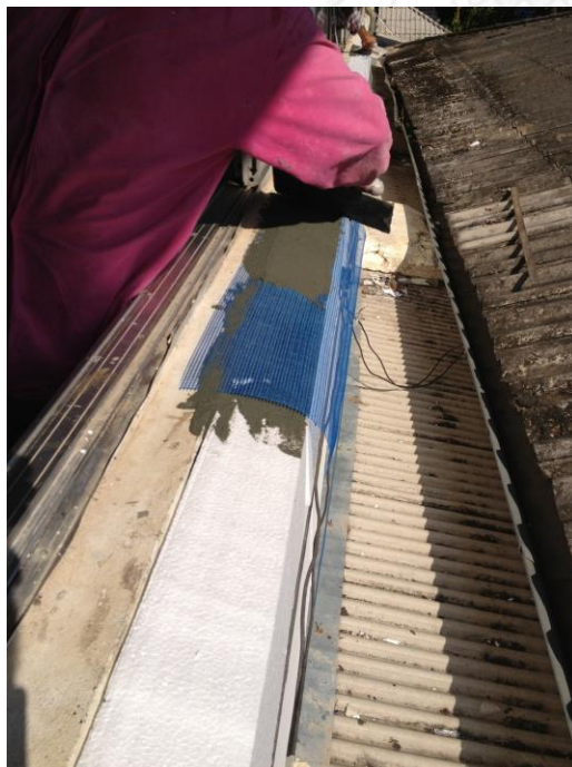
(ค) การฉาบปูนกาวปิดผิวตาข่ายไฟเบอร์กลาส (ง) การฉาบปูนกาวจนเต็มพื้นที่ฉนวน
