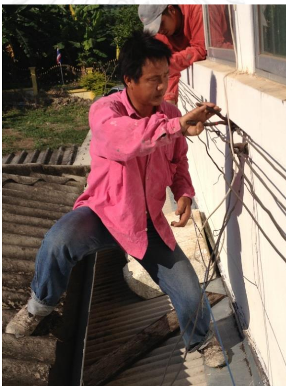
รูปที่ 4 - 16 แสดงขั้นตอนการขยับเลื่อนสายไฟบนผนังด้วยคีมปากนกแก้ว (บันทึกภาพวันที่ 18 ธ.ค. 55)
