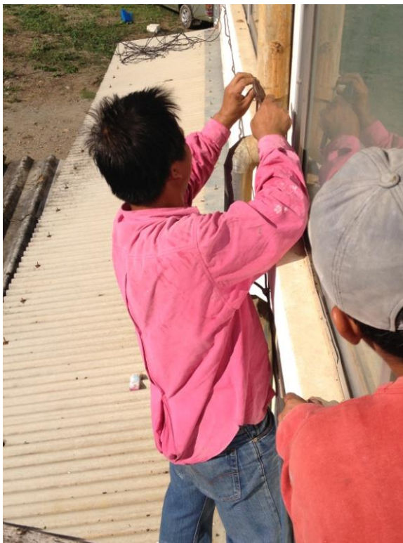
รูปที่ 4 - 17 แสดงขั้นตอนการถอดท่อระบายน้ำฝนออกเพื่อปรับสภาพผนังให้พร้อมสำหรับการทำความสะอาด (บันทึกภาพวันที่ 18 ธ.ค. 55)
