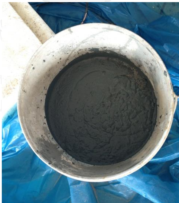
รูปที่ 4 - 18 แสดงส่วนผสมปูนกาวในถังผสมในสัดส่วนส่วนน้ำยารองพื้น 1 ถึงต่อปูน ½ ลูก (บันทึกภาพวันที่ 18 ธ.ค. 55)
