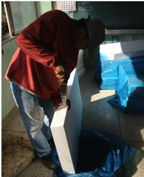
รูปที่ 4 - 21 แสดงวิธีการใช้เลื่อยปลายแหลมเจาะฉนวน (บันทึกภาพวันที่ 18 ธ.ค. 55)
