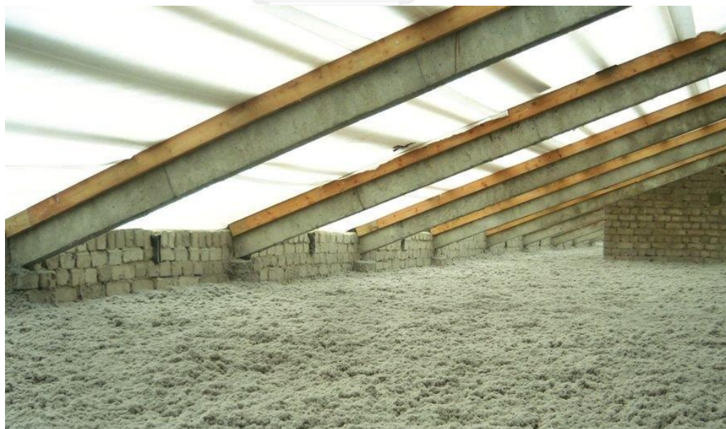
รูปที่ 2 - 1 แสดงตัวอย่างฉนวนเซลลูโลส (Cellulose) สำหรับฉีดพ่น (ที่มา http://img.alibaba.com/photo/106954037/Cellulose_insulation_material.jpg )
