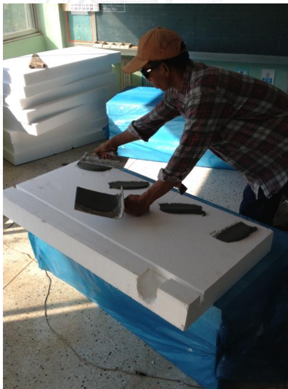
รูปที่ 4 - 23 แสดงถึงการฉาบปูนกาวด้านหลังฉนวนโดยเว้นระยะห่างประมาณ 0.30 เมตร (บันทึกภาพวันที่ 18 ธ.ค. 55)
