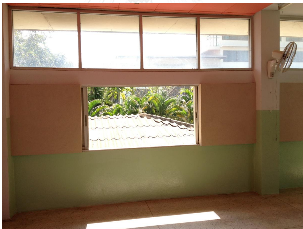
รูปที่ 4 - 33 แสดงผนังภายในห้องหลังการติดตั้ง (บันทึกภาพวันที่ 27 ธ.ค. 55)
