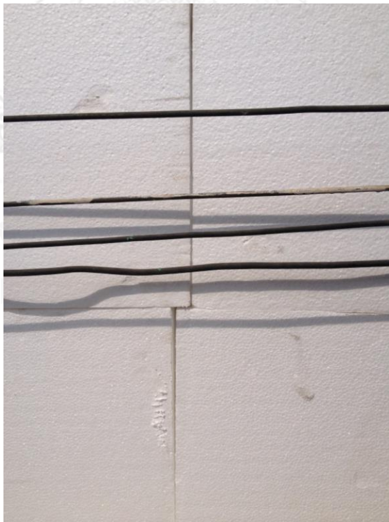
รูปที่ 4 – 27 แสดงรอยต่อระหว่างฉนวนที่ควรเรียบเสมอกัน (บันทึกภาพวันที่ 18 ธ.ค. 55)
