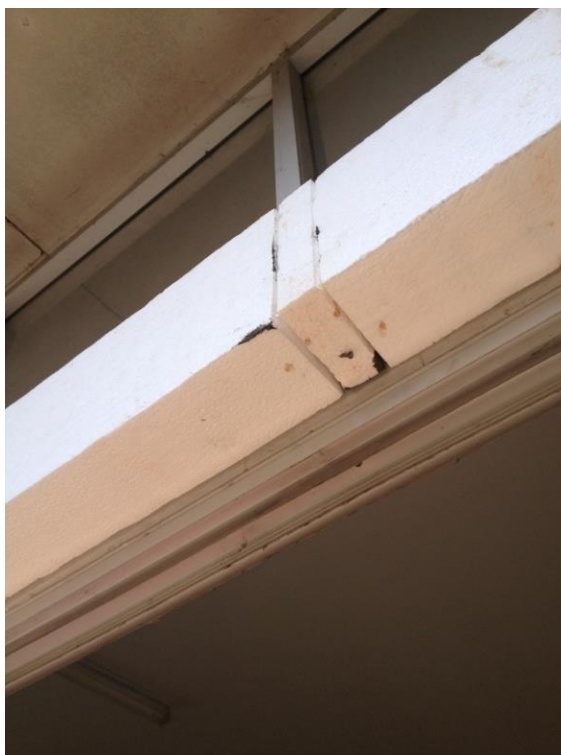
รูปที่ 4 – 28 แสดงการใช้เศษโฟมอุดในช่องว่าง ในกรณีที่เหล็กระยะห่างระหว่าง ฉนวน (บันทึกภาพวันที่ 18 ธ.ค. 55)
