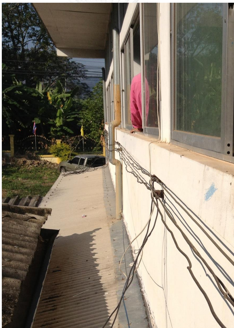
รูปที่ 4 - 10 แสดงสภาพผนังที่ทำการติดตั้งฉนวน (บันทึกภาพวันที่ 18 ธ.ค. 55)
