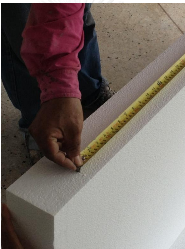
รูปที่ 4 - 19 แสดงวิธีการใช้ตลับเมตรบากรอยบนเนื้อวัสดุ (บันทึกภาพวันที่ 18 ธ.ค. 55)
