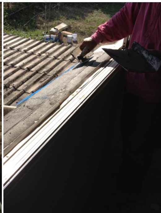
(ค) การฉาบปูนกาวปิดผิวตาข่ายไฟเบอร์กลาส (ง) การฉาบปูนกาวจนเต็มพื้นที่ฉนวน
