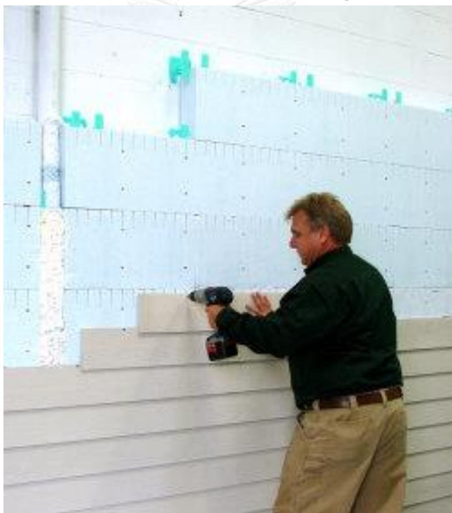
รูปที่ 2 – 10 แสดงการใช้สกรูยึดแผ่นไม้บนโฟม EPS (ที่มา
