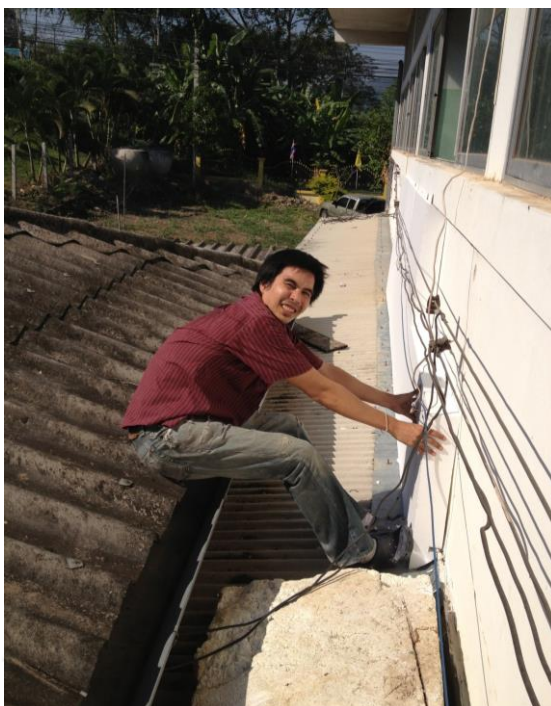
รูปที่ 4 – 24 แสดงวิธีการกวดฉนวนแนบติดกับผนังอย่างน้อย 30 วินาทีเพื่อให้ปูน กาวแห้ง (บันทึกภาพวันที่ 18 ธ.ค. 55)
