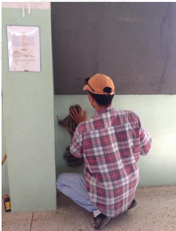
รูปที่ 4 - 32 แสดงการใช้ผ้าขี้ริ้วชุบน้ำหมาดเช็ดทำความสะอาด (บันทึกภาพวันที่ 20 ธ.ค. 55)
