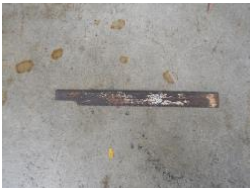
รูปที่ 3.254 แผ่นเหล็กสำหรับทำแนวรูเจาะใส่ละมาน
