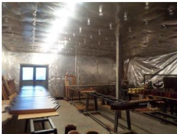
รูปที่ 3.198 ห้องสะท้อนความร้อนที่บุนนวมกันความร้อนไว้โดยรอบ
