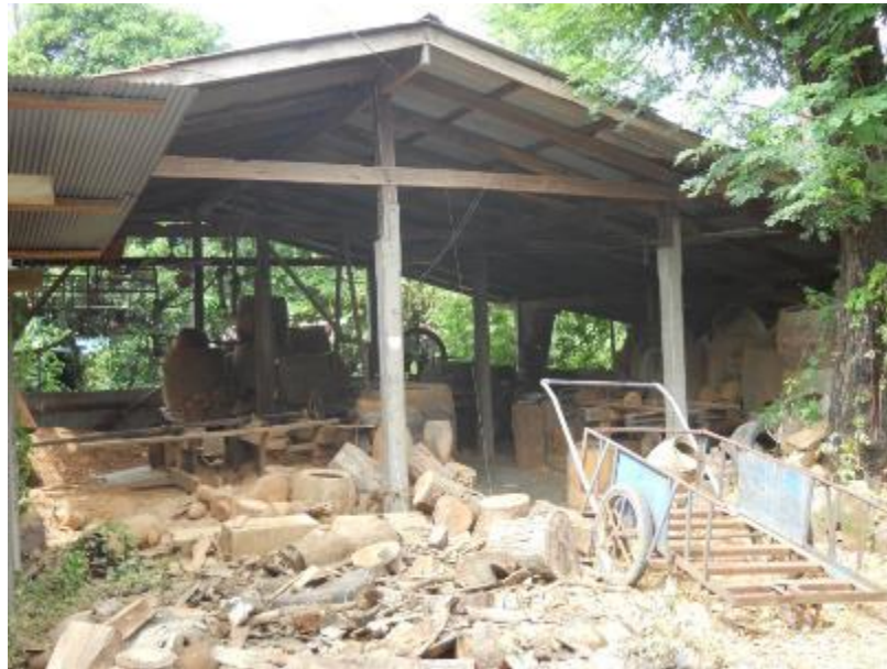
รูปที่ 3.373 โรงไม้และโรงกลึงกลองในบริเวณบ้าน
