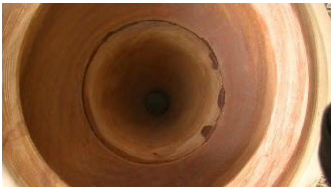
รูปที่ 3.338 รอยต่อและประสานกาวบริเวณตำแหน่งเข้าเดือยไม้ (ด้านใน)
