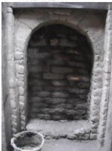
รูปที่ 3.134 ช่องประตูข้างเตาที่ปิดด้วยอิฐและดินยาประตูแล้ว
