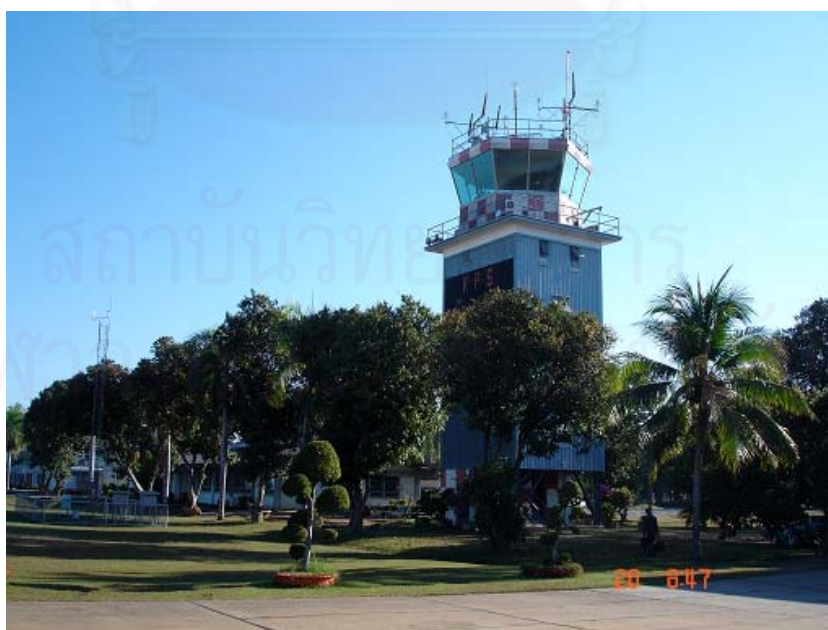
รูปที่ 7.5 หอบังคัมการบินซึ่งใช้ในการติดตั้งระบบภาคพื้น
