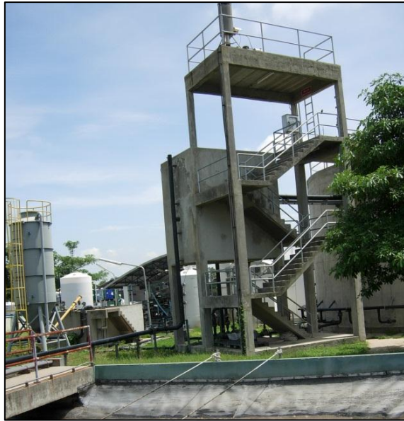
ภาพที่ ก1 ระบบบำบัดแบบยูเอเอสบี ของบริษัททีปโก้ เอฟ แอนด์ บี จำกัด
