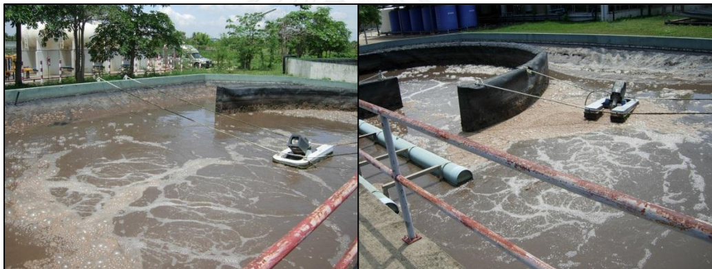
ภาพที่ ก2 ระบบบำบัดน้ำเสียแบบเอสปีอาร์ ของบริษัททีปโก้ เอฟ แอนด์ บี จำกัด
