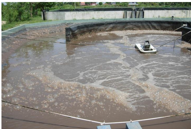
ภาพที่ 21 ระบบบำบัดน้ำเสียแบบเอสบีอาร์ ของบริษัททิปโก้ เอฟ แอนด์ บี
