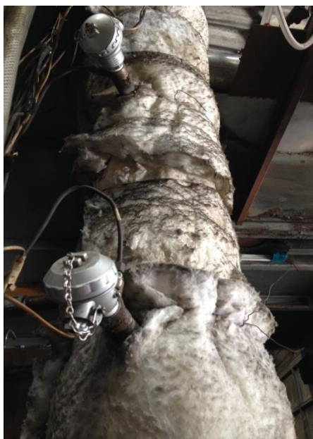
รูปที่ 3.5 ท่อโรเซอร์ของเตาเผาฟลูอิดไชน์เบดแบบหมุนเวียน
