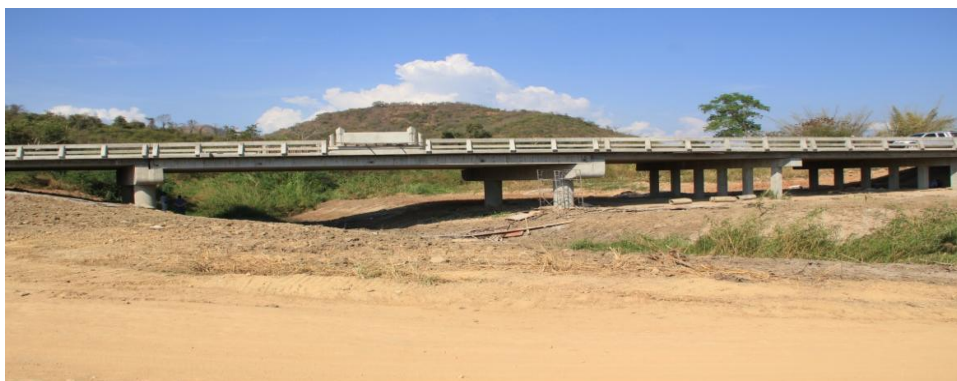
รูปที่ 3.2 สะพานห้วยสามหาง จังหวัดเพชรบุรี
