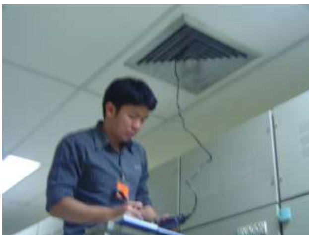
รูปที่ 4.31 การตรวจวัดอุณหภูมิและความชื้นสัมพัทธ์ของอากาศเย็นที่ด้านจ่าย
