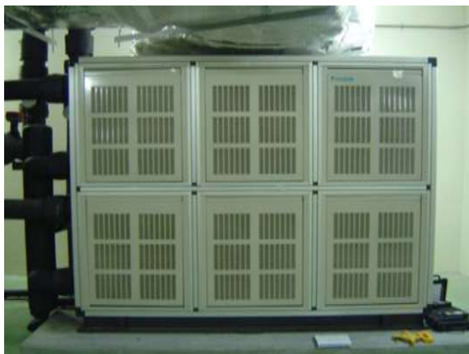
รูปที่ 4.40 ลักษณะช่องลมเข้า AHU หลังปรับปรุง มี 6 ช่องใหญ่ 6 ช่องเล็ก
