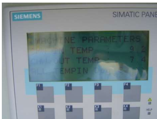
รูปที่ 4.37 ค่าอุณหภูมิ น้ำเย็นอ่านได้จากหน้าปัดเครื่องทำน้ำเย็นแบบดูดซึม
