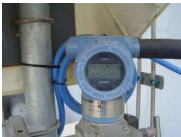
รูปที่ 4.33 จุดอ่านค่าอัตราการไหลของน้ำเย็น
