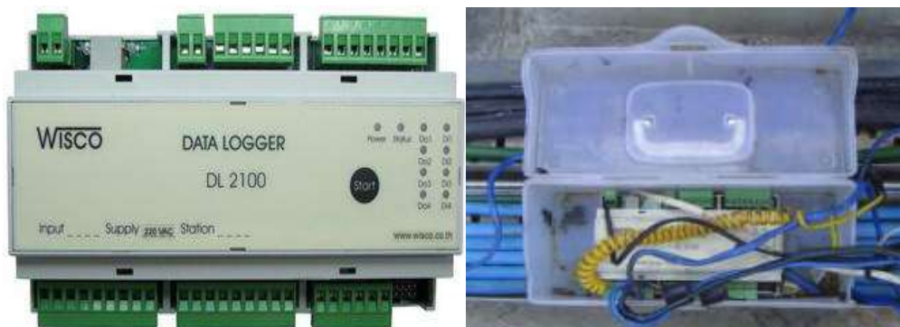
รูปที่ 4.24 Data Logger ที่ใช้ในการบันทึกค่าข้อมูลอุณหภูมิของสิ่งแวดล้อมและน้ำเย็น
