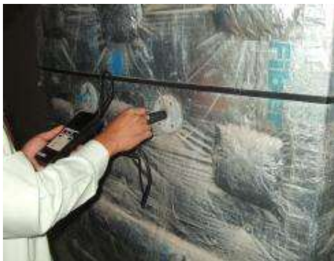
รูปที่ 4.13 วัดอุณหภูมิและความชื้นสัมพัทธ์ของอากาศเย็นที่ด้านจ่ายจากเครื่องส่งลมเย็น
