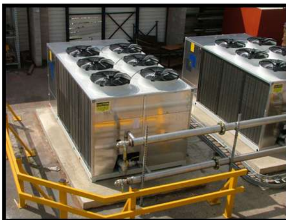
รูปที่ 2.2 เครื่องทำน้ำเย็นแบบระบายความร้อนด้วยอากาศ
