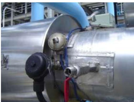
รูปที่ 4.34 การติดตั้งอุปกรณ์การตรวจวัดข้อมูลอุณหภูมิน้ำเย็นขาออก
