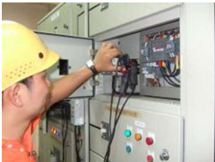
รูปที่ 4.10 การติดตั้งอุปกรณ์วัดกำลังไฟฟ้าของเครื่องส่งลมเย็น
