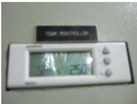
รูปที่ 4.32 ตั้งค่าอุณหภูมิของห้องปรับอากาศก่อนทำการตรวจวัดระบบปรับอากาศแบบดูดซึม
