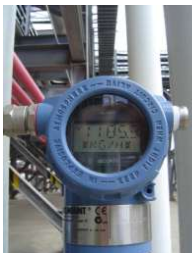
รูปที่ 4.36 หน้าปัดอ่านค่าอัตราไหลไอน้ำร้อนความดันต่ำ
