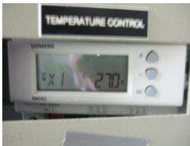
รูปที่ 4.14 การตั้งค่าอุณหภูมิของห้องปรับอากาศก่อนทำการตรวจวัดและเก็บข้อมูลต่างๆ
