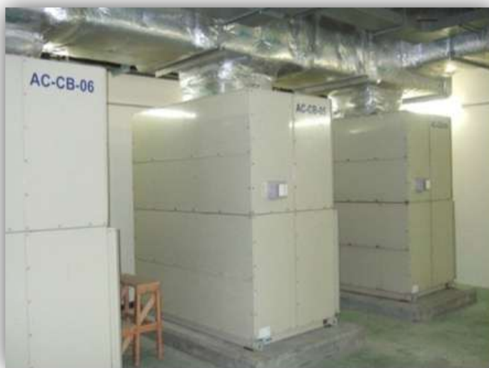
รูปที่ 4.1 ลักษณะการติดตั้งเครื่องส่งลมเย็น
