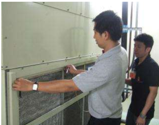
รูปที่ 4.15 การวัดหาค่าขนาดความยาวของช่องลมจากกลับเข้าเครื่องส่งลมเย็น
