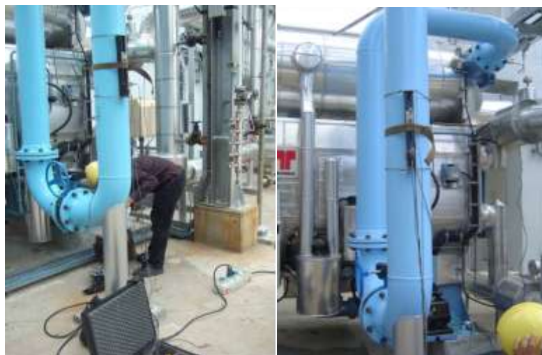
รูปที่ 4.35 การติดตั้งอุปกรณ์วัดอัตราการไหลของน้ำหล่อเย็น
