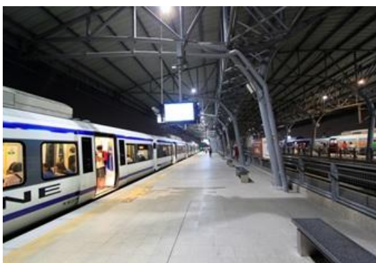
ภาพที่ 44 ภาพตัวอย่างที่ 2 ชานชาลาสถานีรถไฟฟ้า Airport rail link สถานีหัวหมาก
