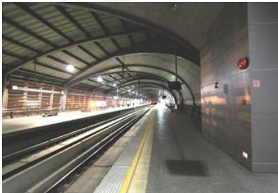
ภาพที่ 43 ภาพตัวอย่างที่ 1 خانชาลาสถานีรถไฟ Airport rail link สถานีลาดกระบัง
