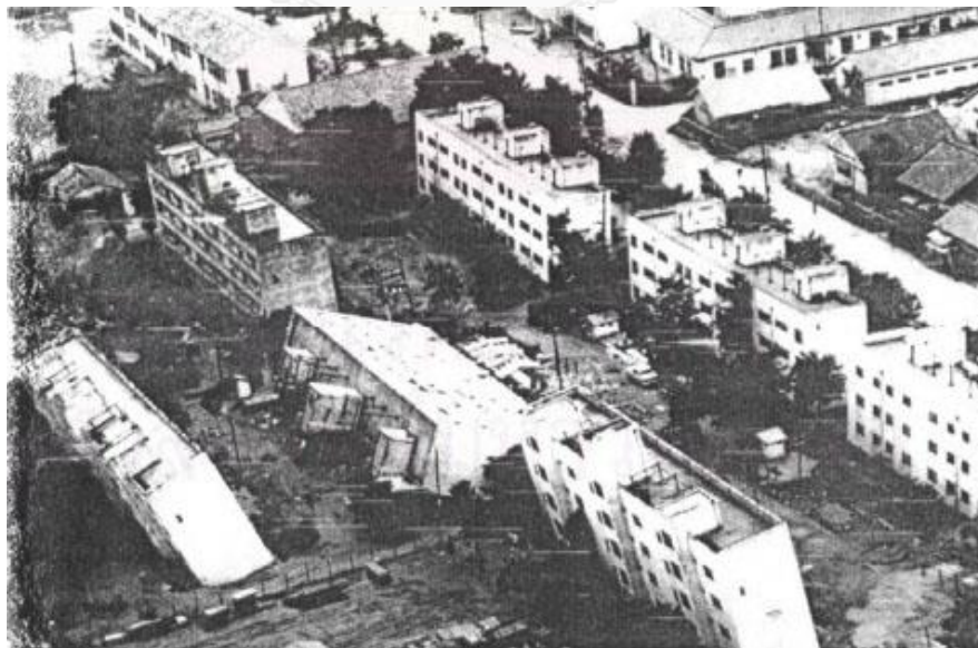
รูปที่ 2.14 การพลิกคว่ำของอาคารที่พักอาศัย, นิงาตะ (1964) (พิชัย ภัทรรัตนกุล, 2546)
