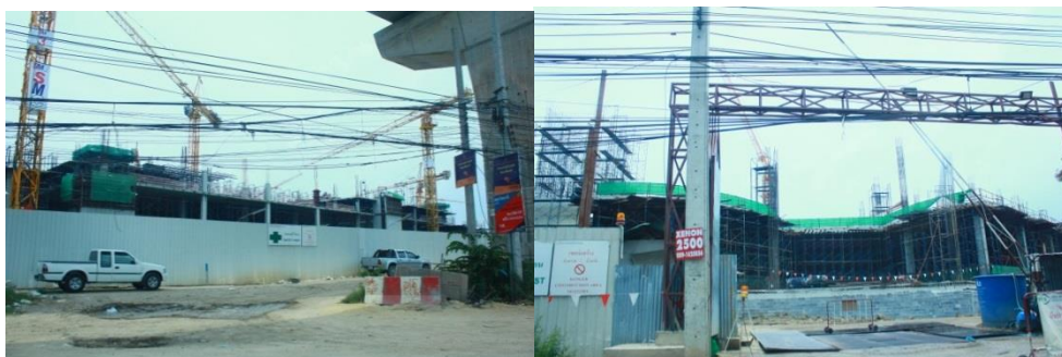
ภาพที่ 72 แสดงพื้นที่ก่อสร้างห้างสรรพสินค้าเซ็นทรัล เวสต์เกต บริเวณสถานีรถไฟฟ้าตลาดบางใหญ่ ที่มา : จากการลงสำรวจพื้นที่ (เดือนเมษายน พ.ศ.2557)
