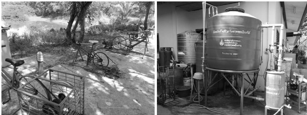
รูป 9 จักรยานสำหรับปั่นไฟและถังหมักก๊าซชีวภาพภายในศูนย์การเรียนรู้ พลังงานทดแทนของโรงเรียนสัตยาไส
