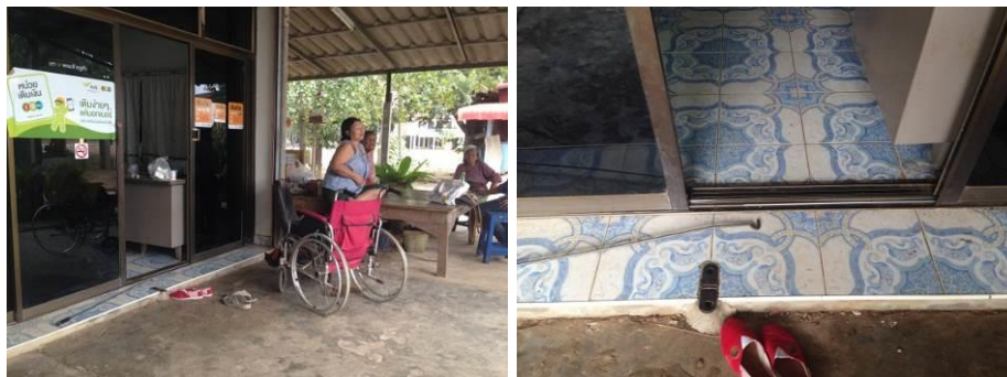
บริเวณด้านหน้าห้องนอน มีพื้นต่างระดับ 2 เซนติเมตร
