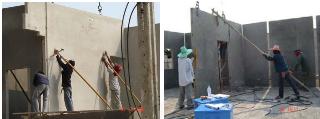
รูปที่ 5.25 และรูปที่ 5.26 การติดตั้งค้ำยันผนัง
