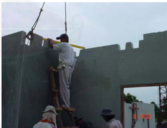
รูปที่ 5.28 การตรวจสอบระดับผนัง
