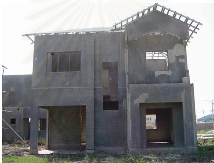
รูปที่ 3.43 โครงสร้างเสร็จสมบูรณ์
