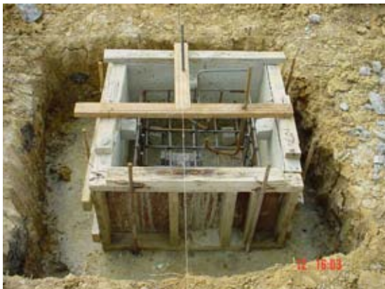
รูปที่ 3.13 แบบหล่อไม้
