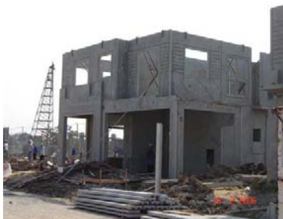
รูปที่ 3.41 โครงสร้างเสร็จสมบูรณ์
