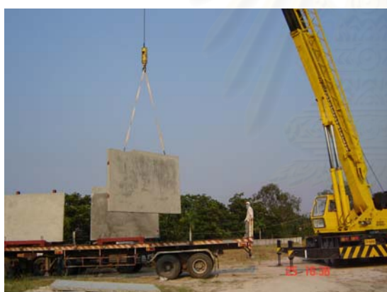
รูปที่ 3.21 รถเครนยกผนังคอนกรีตสำเร็จรูป
