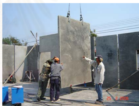
รูปที่ 3.22 คนงานจับและดันผนังให้ได้ตำแหน่ง
