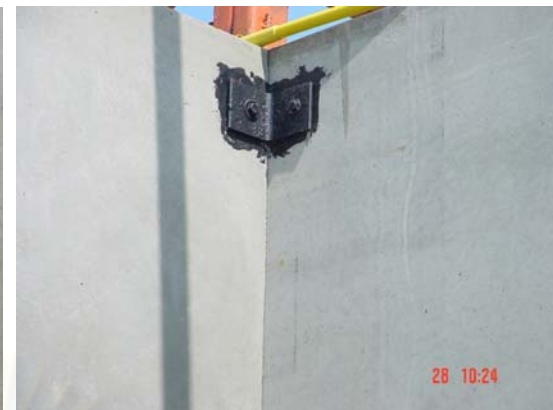
รูปที่ 3.26 การยึดสลักเกลียวรอยต่อผนัง
