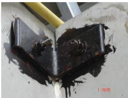
รูปที่ 5.19 การยึดระหว่างรอยต่อผนังด้านในด้วยสลักเกลียว
