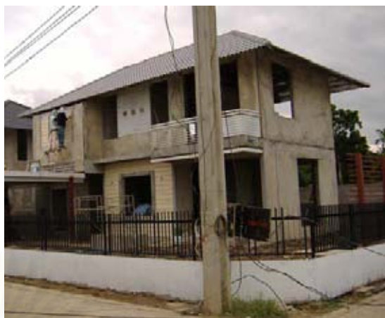
รูปที่ 3.42 โครงสร้างเสร็จสมบูรณ์
