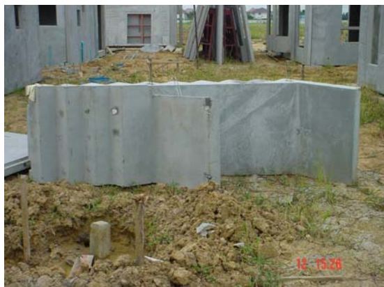
รูปที่ 3.28 การจัดเก็บบันไดคอนกรีตสำเร็จรูป
