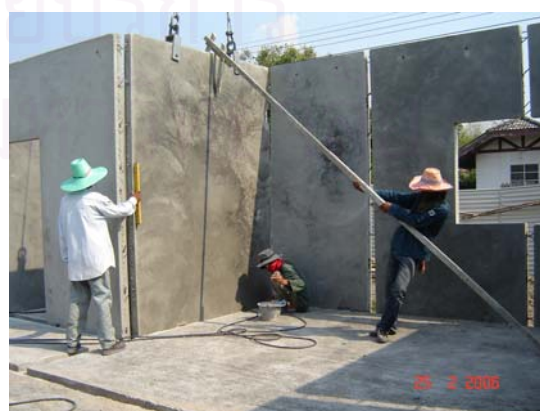
รูปที่ 3.24 คนงานตรวจสอบระดับแผ่นผนัง
