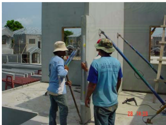
รูปที่ 5.27 การติดตั้งผนังให้ได้ตั้ง
