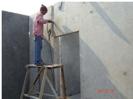
รูปที่ 3.25 คนงานเชื่อมรอยต่อผนัง
