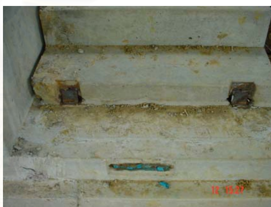
รูปที่ 3.30 – รูปที่ 3.31 การประสานรอยต่อบันไดคอนกรีตสำเร็จรูป
