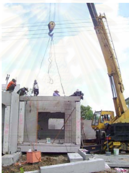
รูปที่ 3.16 คนงานติดตั้งคานชั้น 2
