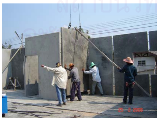
รูปที่ 3.23 คนงานจัดผนังให้ได้ตำแหน่ง
