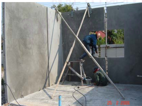
รูปที่ 3.8 ค้ำยันไม้
