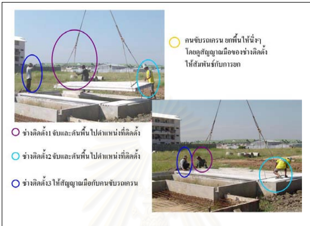
รูปที่ ก.4 งานติดตั้งพื้นชั้น 1
