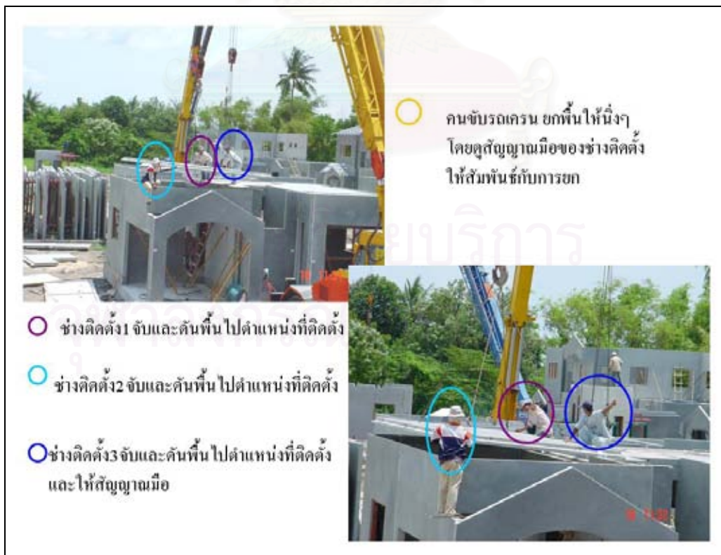
รูปที่ ก.5 งานติดตั้งพื้นชั้น 2
