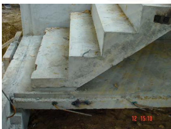
รูปที่ 3.30 – รูปที่ 3.31 การประสานรอยต่อบันไดคอนกรีตสำเร็จรูป
