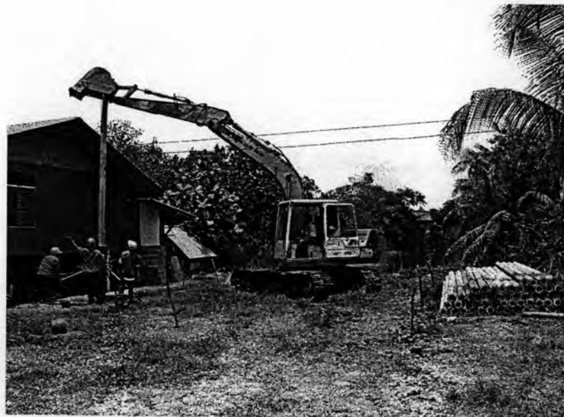
รูปที่ 5.11 การประยุกต์ใช้เครื่องมือช่วยตอกเสาเข็มคอนกรีตสั้น
