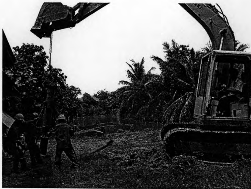
รูปที่ 5.12 การติดตั้งเครื่องมือช่วยตอกเสาเข็มคอนกรีตสั้น
