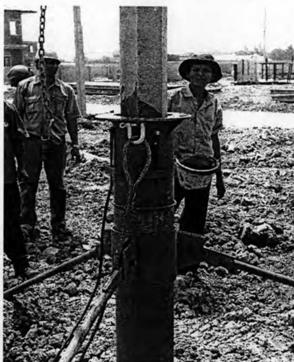
รูปที่ 5.15 เครื่องมือช่วยตอกเสาเข็มคอนกรีตสั้นเมื่อประยุกต์ใช้กับเสาเข็มความยาว 4 เมตร
