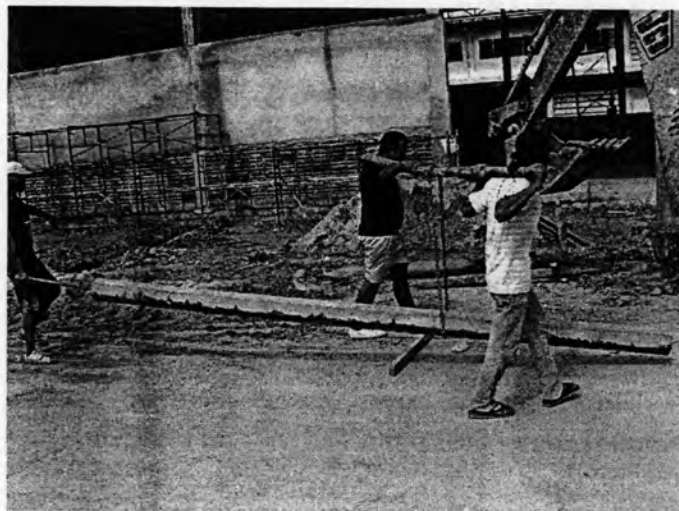
รูปที่ 4.1 การเคลื่อนย้ายเสาเข็มโดยใช้กำลังคนจำนวน 3 คน
