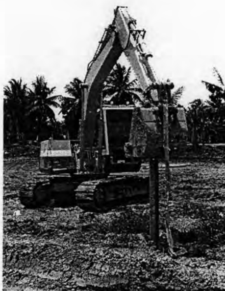
รูปที่ 4.7 การตรวจสอบระนาบตั้ง ของวิธีการส่งเสาเข็มให้ได้ระดับโดยใช้เครื่องจักรขุดดิน
