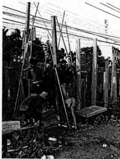
รูปที่ 4.6 การปรับตั้งแนวตั้งของเสาเข็มของวิธีการส่งเสาเข็มโดยกำลั้งคน
