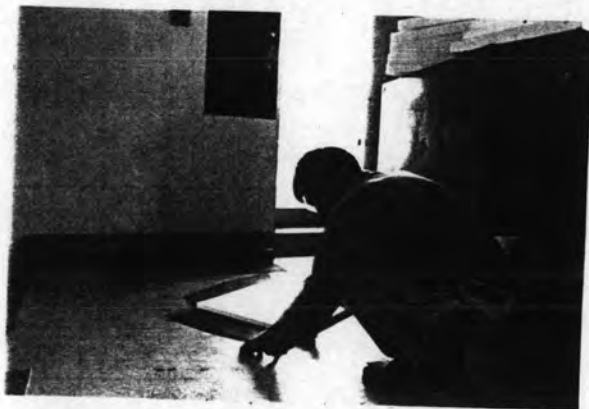
(3) การหุ้มด้วยตะข่าย FIBREGLASS MESH) หุ้มริมขอบทั้ง 4 ด้าน
