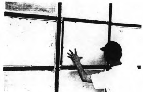
(10) กดฉนวนโคมให้ยึดเกาะผนังได้สนิทแน่น
