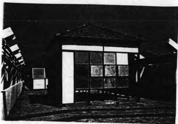
(13) เมื่อฉาบผิวเสร็จทิ้งไว้ 1 วันเพื่อรอให้แห้งและ SET ตัว
