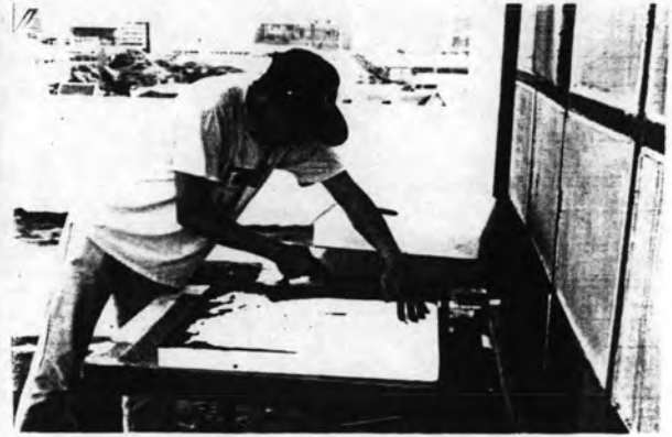
(8) นำส่วนผสมที่เข้ากันดีแล้วมาฉาบหลังโคม พร้อมยึดตะขอยึดให้ติดกับโคม
