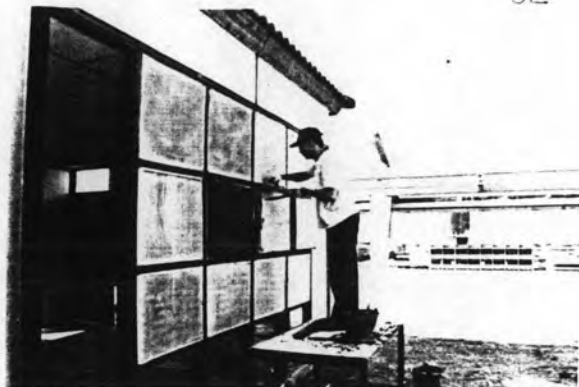
(12) นำส่วนผสมแบบเดิมในอัตราส่วน 4 : 3 มาฉาบผิว ไฟมกับตะขாயเพิ่มความแข็งแรง ( BASE COAT : ซีเมนต์ )
