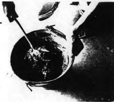
(7) นำ BASE COAT กับ ซีเมนต์ PORTLAND ผสมให้เข้ากัน ในอัตราส่วน 1:1 สำหรับยึดติดกับผนังก่ออิฐฉาบปูน
