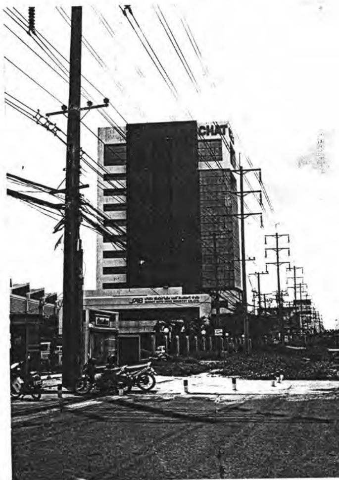
สภาพอาคารสำนักงานริมถนนบางนา-ตราด
