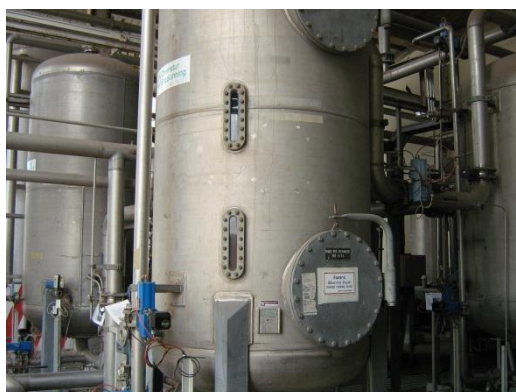
รูปที่ 3.4 ถังแลกเปลี่ยนไอออนประจุบวกและลบ (Mixed bed Exchanger)
