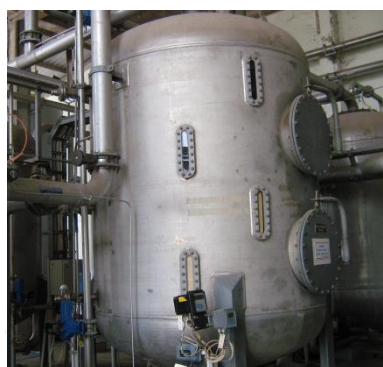
รูปที่ 3.3 ถังแลกเปลี่ยนไอออนประจุลบ (Anion Exchanger)
