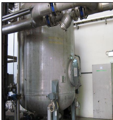
รูปที่ 3.2 ถังแลกเปลษยนไอออนประจุบวก (Cation Exchanger)
