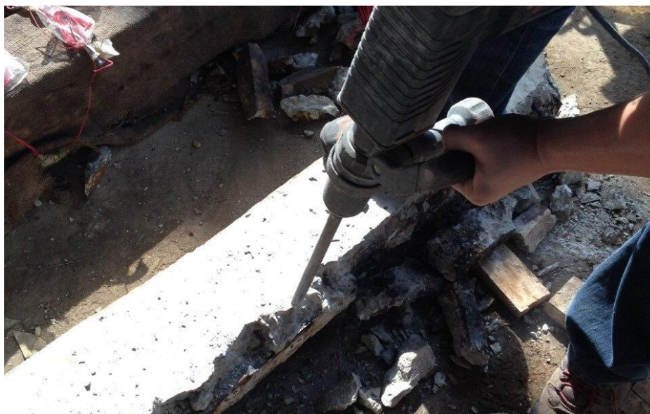
รูปที่ 3.10 ขั้นตอนการสกัดคอนกรีต
