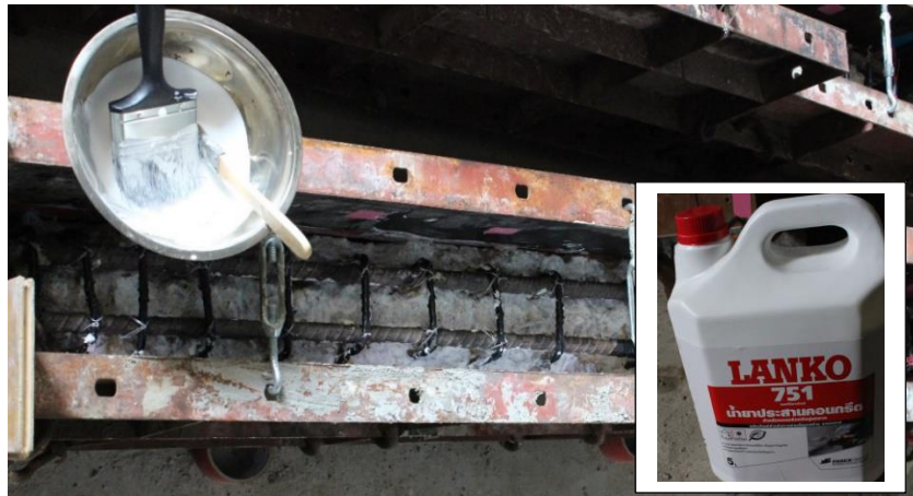
รูปที่ 3.15 ขั้นตอนการทาน้ำยาประสานคอนกรีต
