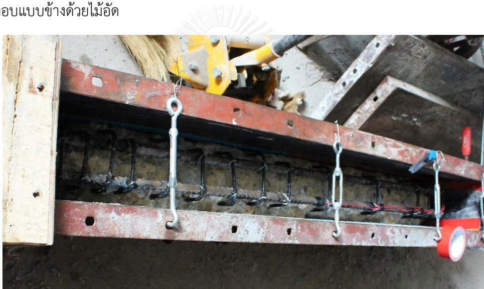
รูปที่ 3.14 การติดตั้งแบบหล่อเพื่อการซ่อมแซม
