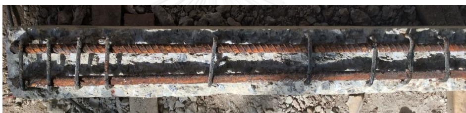
รูปที่ 3.11 คอนกรีตหลังจากสกัดส่วนที่เสียหายที่สนิมออกแล้ว
