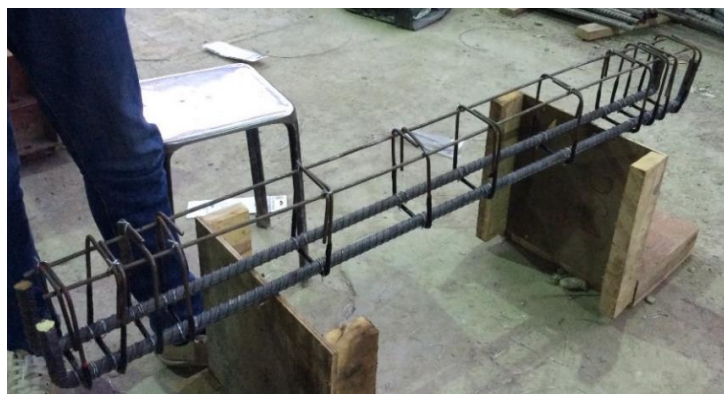
(ก) ขั้นตอนการผูกเหล็กเสริม
