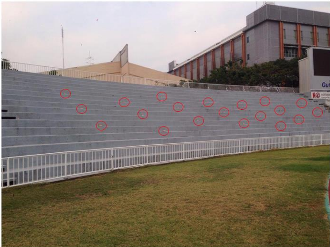
รูปที่ 3.4 แสดงพื้นที่บนอัฒจันทร์ในการติดตั้งเป้าสามมิติครอบคลุมบริเวณที่สแกน
