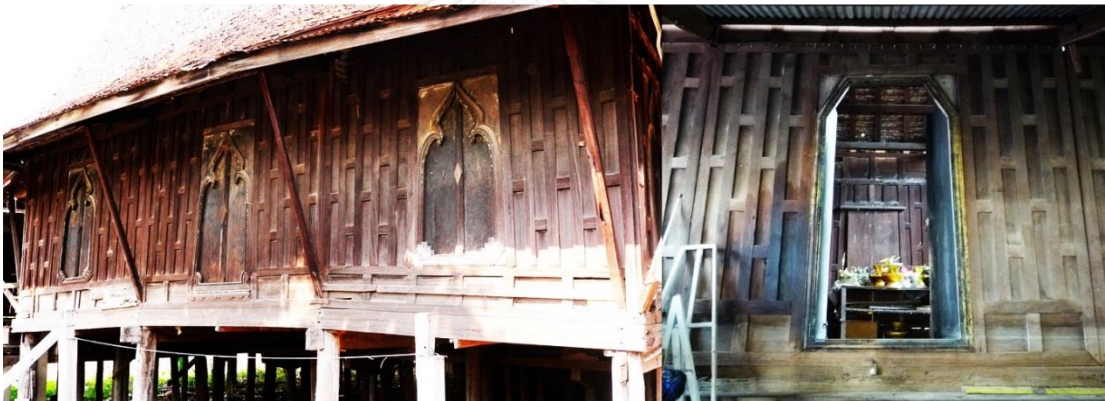
ภาพที่ 135 และ ภาพที่ 136 ภาพแสดงลักษณะการทรุดเอียงของตัวเรือนตำหนักทองและสภาพในปัจจุบัน
