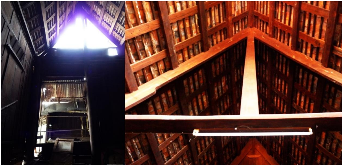
ภาพที่ 142 และ ภาพที่ 143 ภาพแสดงลักษณะความเสียหายของผนังและหน้าจั่วเรือนตำหนักทอง และภาพแสดงส่วนโครงสร้างหลังคาและลักษณะการมุงกระเบื้องหลังคาของเรือนตำหนักทอง
