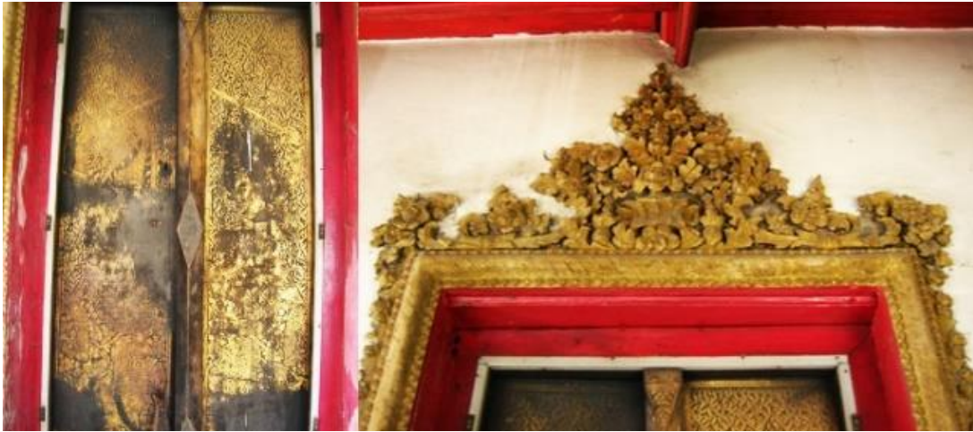
ภาพที่ 11 และ ภาพที่ 12 ภาพแสดงส่วนที่ชำรุดของบานประตูและส่วนที่ชำรุดของลวดลายปูนปั้นกรอบหน้าต่างของหอพระไตรปิฎก วัดเทพธิดาราม (ที่มาของภาพ โครงการอนุรักษ์หอพระไตรปิฎกวัดเทพธิดารามวรวิหาร กรุงเทพมหานคร)
