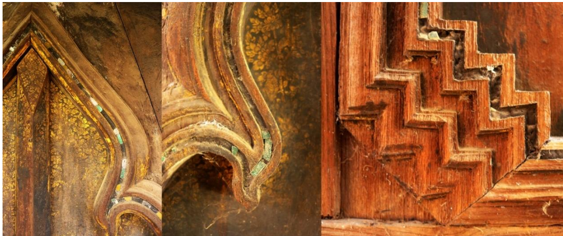
ภาพที่ 148 ภาพที่ 149 และ ภาพที่ 150 ภาพแสดงลักษณะการเขียนลวดลาย การประดับกระจกสี และการแกะสลักไม้ของซุ้มหน้าต่าง
