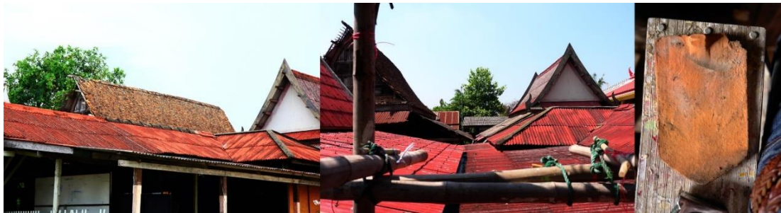
ภาพที่ 90 ภาพที่ 91 และ ภาพที่ 92 ภาพแสดงวัสดุผนังหลังคาของหมู่กุฏิวัดสามโคก ซึ่งประกอบด้วย 2 ชนิด คือ กระเบื้องดินเผาและสังกะสี
