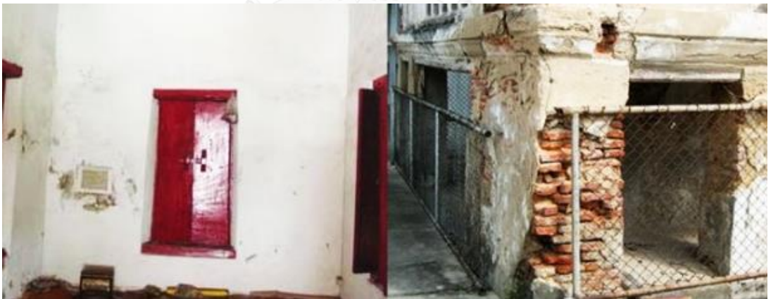
ภาพที่ 9 และ ภาพที่ 10 ภาพแสดงส่วนที่ชำรุดของฉิวปูนฉาบของหอพระไตรปิฎกวัดเทพธิดาราม (ที่มาของภาพ โครงการอนุรักษ์หอพระไตรปิฎกวัดเทพธิดารามวรวิหารกรุงเทพมหานคร)
