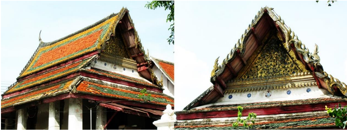
ภาพที่ 5 และ ภาพที่ 6 ภาพแสดงส่วนที่ชำรุดเสียหายของหลังคาหอพระไตรปิฎกวัดเทพธิดาราม (ที่มาของภาพ โครงการอนุรักษ์หอพระไตรปิฎกวัดเทพธิดารามวรวิหาร กรุงเทพมหานคร)
