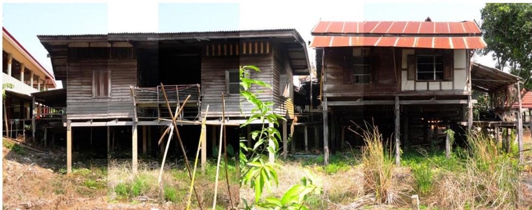
ภาพที่ 164 ภาพแสดงสภาพปัจจุบันภายนอกของอาคารเรือนภูมิหลังที่ 1 และอาคารเรือนภูมิหลังที่ 2 ภายในหมู่กุฏิวัดสามโคก
