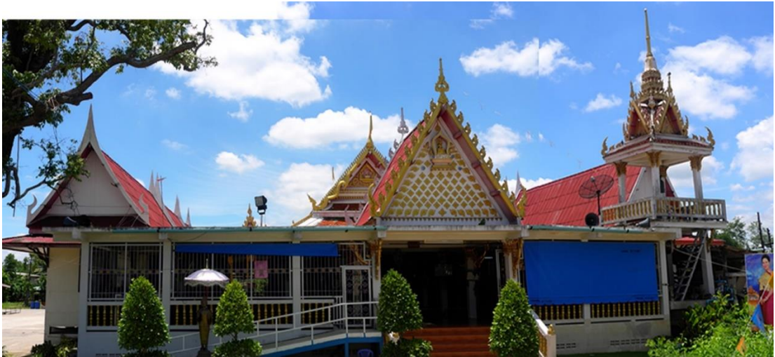
ภาพที่ 23 ภาพแสดงรูปทรงอาคารและทางเข้าด้านหน้าของหมู่กุฏิสงฆ์วัดตำหนัก
