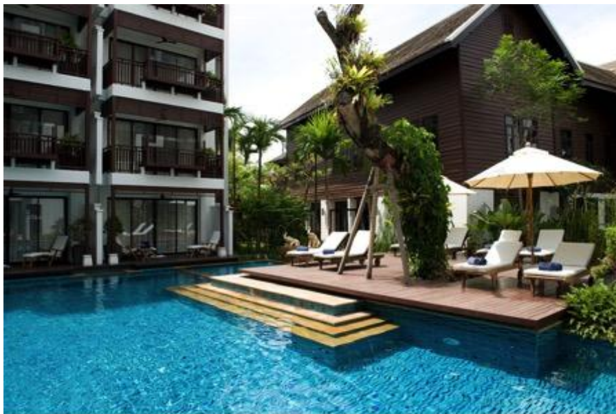
ภาพที่1.6 ภาพด้านหลังอาคารติดกับสระว่ายน้ำและอาคารที่พัก
