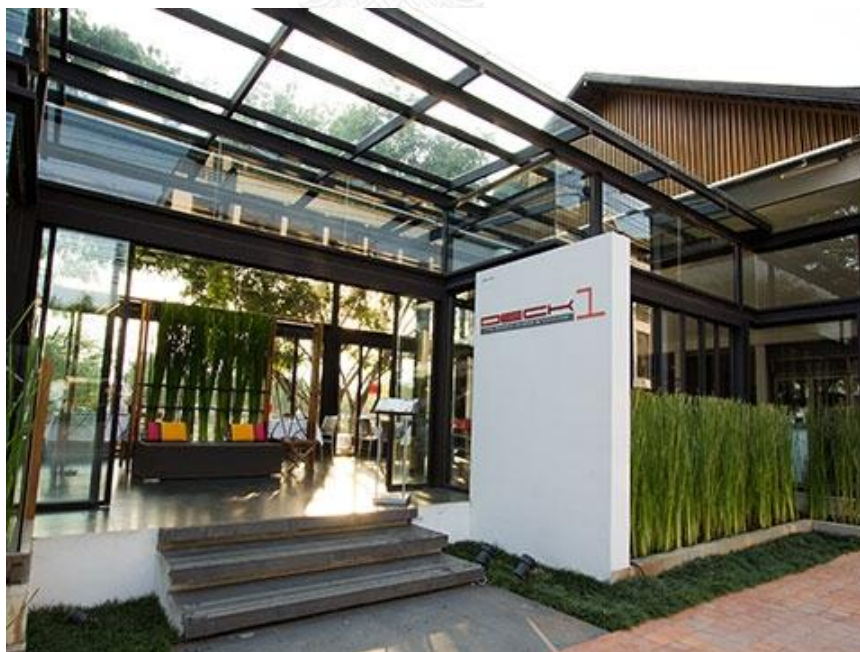
ภาพที่4. 37บริเวณทางเข้าห้องอาหาร Deck 1
