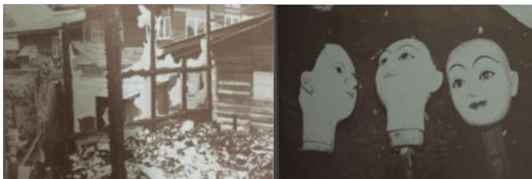
ภาพที่ 2.19 (ต่อ) ภาพจากเหตุการณ์ไฟไหม้บ้านนายสาคร ยังเขียวสด ณ ซอยระนอง 2
