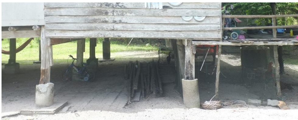
ภาพที่ 4.5 ไม้ที่ใช้ในการก่อสร้างเรือน ชาวบ้านจะเก็บไม้ที่ล้มจากล้มพายุ โดยไม่ตัดจากต้นและนำมาเก็บบริเวณใต้ถุนเรือน เพื่อรักษาคุณภาพเนื้อไม้
