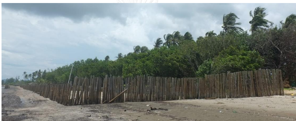
ภาพที่ 3.54 การปักไม้ไผ่เป็นกำแพงกันคลื่น
