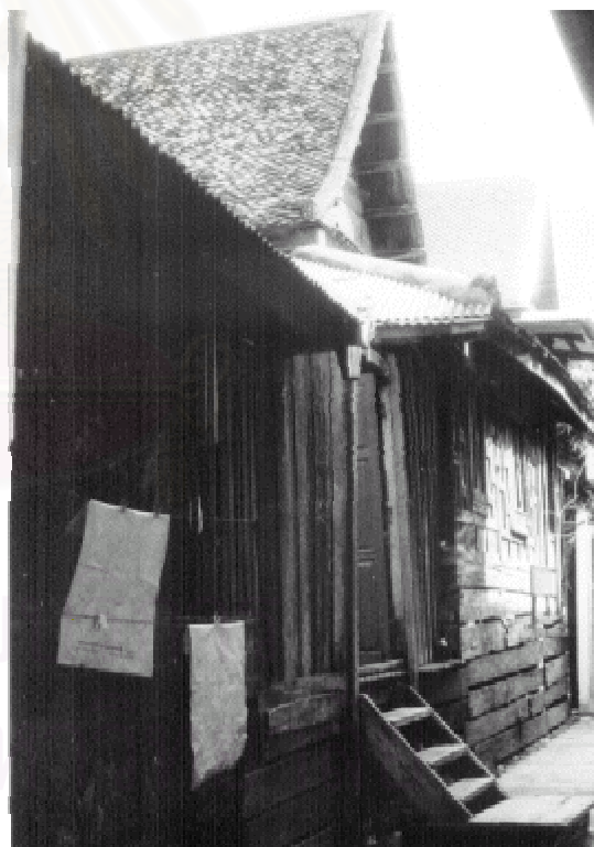
ภาพที่ 4.1.12 : บริเวณพื้นชานที่ถูกรื้อทิ้งไป การกั้นฝาและทำประตูทางเข้า (จากการสำรวจของผู้วิจัย ตุลาคม 2543)
