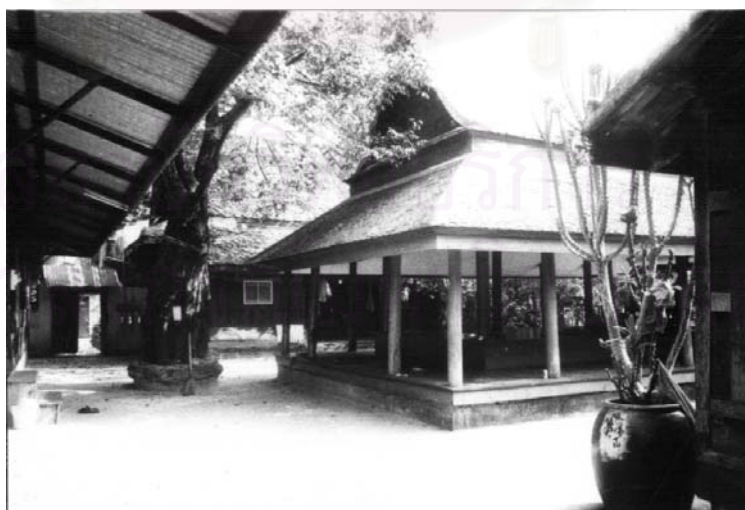
ภาพถ่าย 5.1.7 : การต่อเติมกันสาดในบริเวณระเบียงที่มีชายคาสั้นเพื่อป้องกันแดด (จากการสำรวจของผู้วิจัย ตุลาคม 2543)
