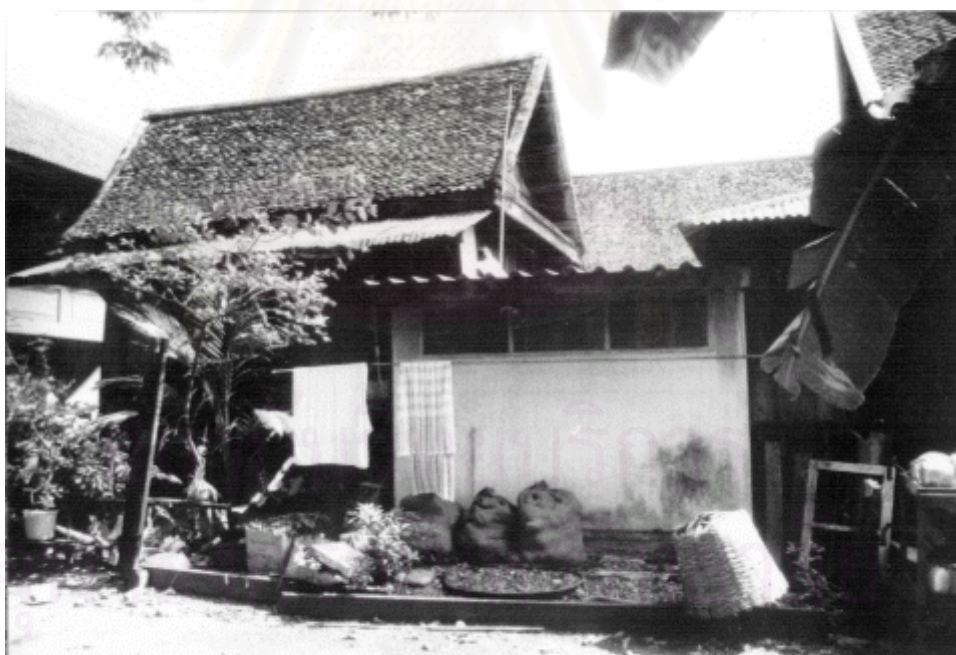
ภาพที่ 4.1.10 : การต่อเติมห้องน้ำอยู่ระหว่างหอฉันกับกุฏิครัว (จากการสำรวจของผู้วิจัย ตุลาคม 2543)
