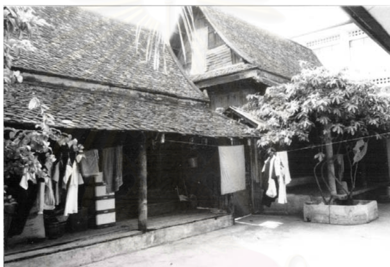
ภาพถ่าย 5.1.10 : สภาพกระเบื้องมุงหลังคา และปูนปั้นสันหลังคา อยู่ในสภาพชำรุดทรุดโทรม และมีการเสื่อมสภาพมาก ทำให้หลังคารั่ว (จากการสำรวจของผู้วิจัย ตุลาคม 2543)
