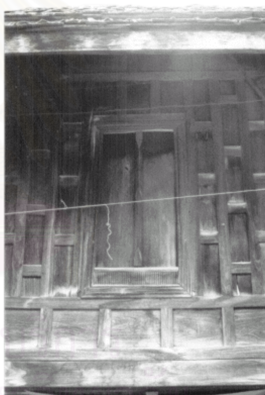
ภาพถ่าย 4.3.12 : ฝากุฏิ มีการเสื่อมสภาพบริเวณลูกฟักที่อยู่ด้านล่าง การเดินสายไฟโดยแชนห้อยไปกับฝา (จากการสำรวจของผู้วิจัย ตุลาคม 2543)
