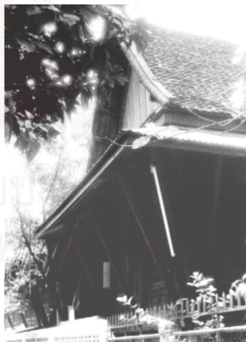
ภาพถ่าย 4.2.12 : การติดตั้งหลอดไฟบริเวณค้ำยันใช้วิธี การเดินสายห้อยไปตามฝาไม้ (จากการสำรวจของผู้วิจัย กันยายน 2543)
