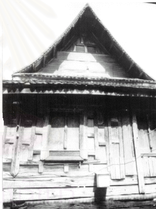
ภาพที่ 4.1.14 : สภาพส่วนตัวอาคาร ฝามีการผุพังและมีการเดินสายไฟห้องไปตามฝา (จากการสำรวจของผู้วิจัย ตุลาคม 2543)
