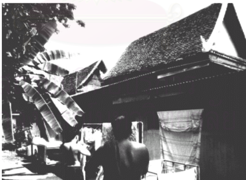
ภาพที่ 4.1.15 : สภาพส่วนหลังคา กระเบื้องและปูนปั้นมีสภาพชำรุดทรุดโทรม (จากการสำรวจของผู้วิจัย ตุลาคม 2543)
