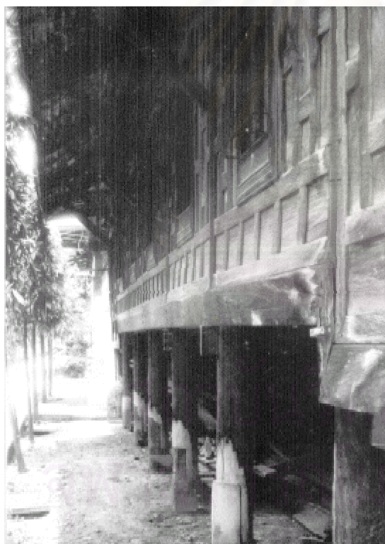
ภาพที่ 4.1.11 : สภาพของส่วนฐานอาคาร (จากการสำรวจของผู้วิจัย ตุลาคม 2543)
