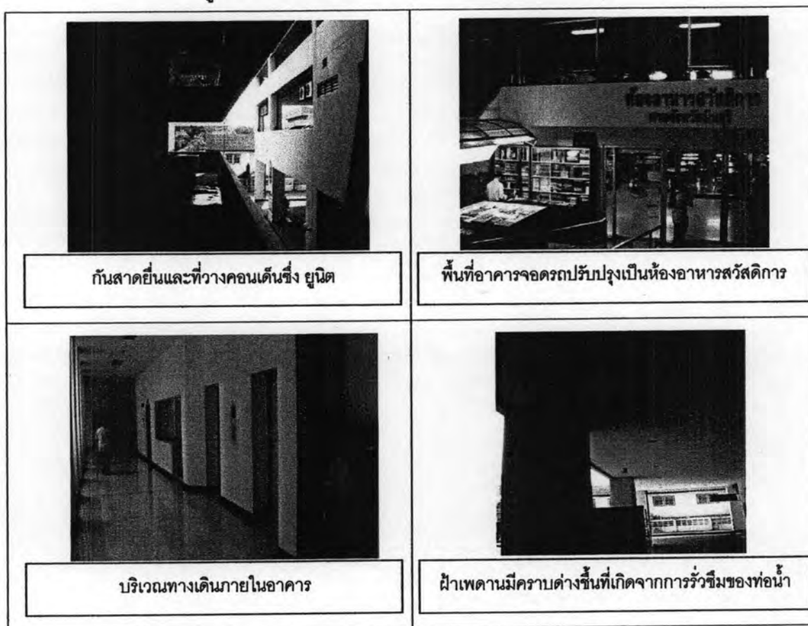
รูปที่ 3.30 สภาพทั่วไปของอาคารศาลจังหวัดมีนบุรี
