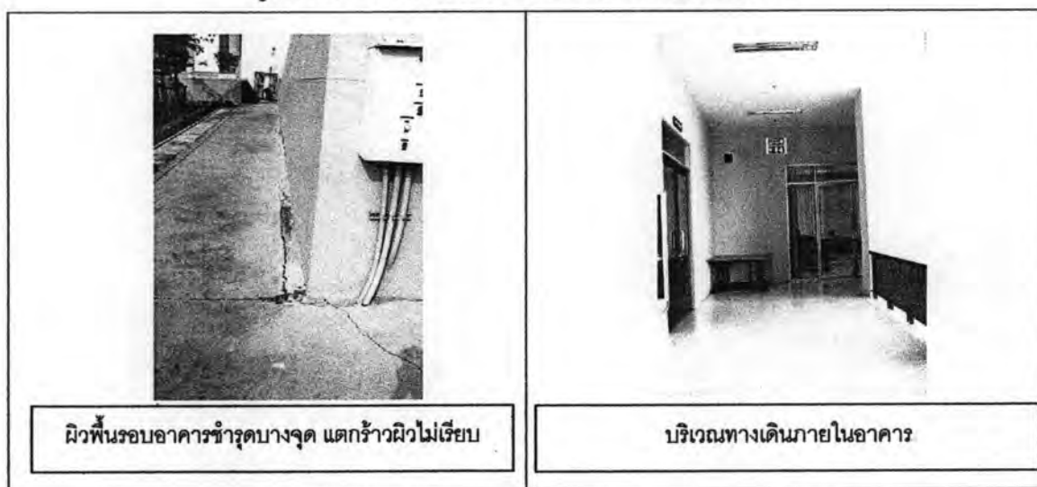
รูปที่ 3.38 สภาพทั่วไปของอาคารศาลจังหวัดดลิ่งชัน
