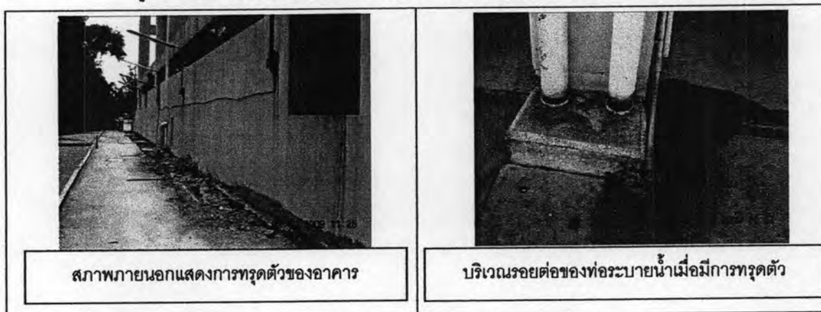
รูปที่ 3.7 สภาพทั่วไปของอาคารศาลแพ่งธนบุรี และศาลอาญาธนบุรี
