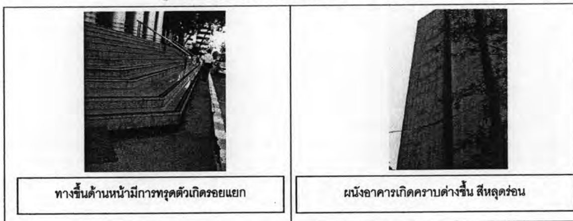
รูปที่ 3.14 สภาพภายนอกของอาคารศาลแพ่ง
