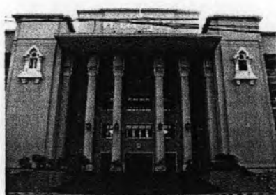
บริเวณทางขึ้นด้านหน้าอาคาร
