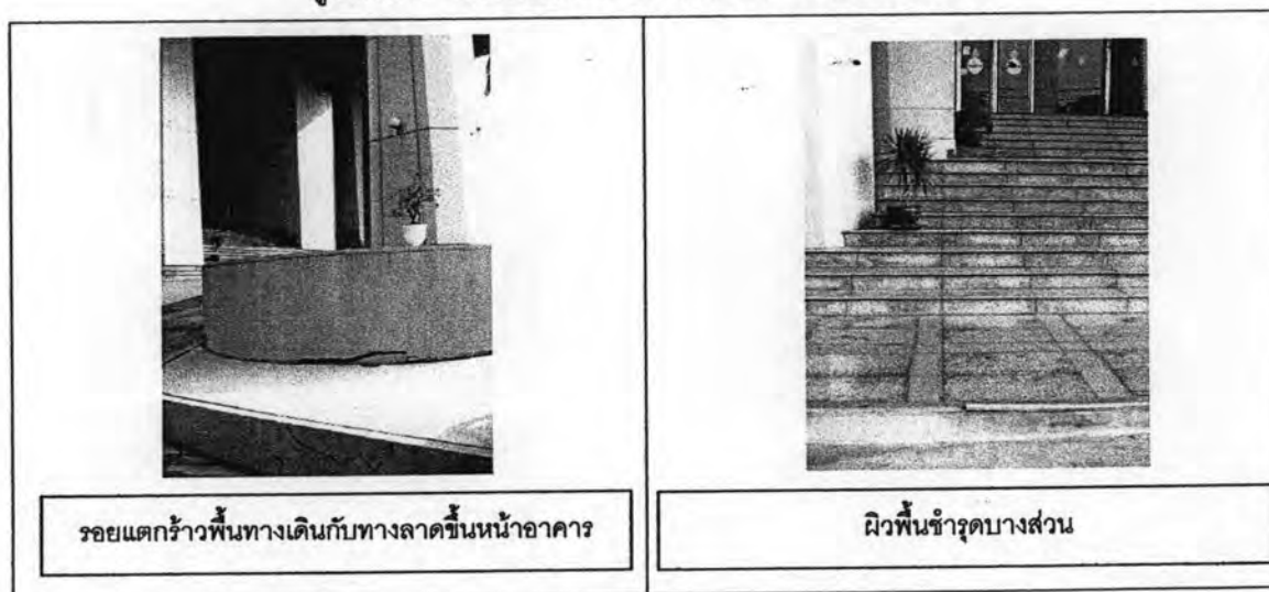
รูปที่ 3.37 สภาพทั่วไปของอาคารศาลจังหวัดดตลิ่งชัน
