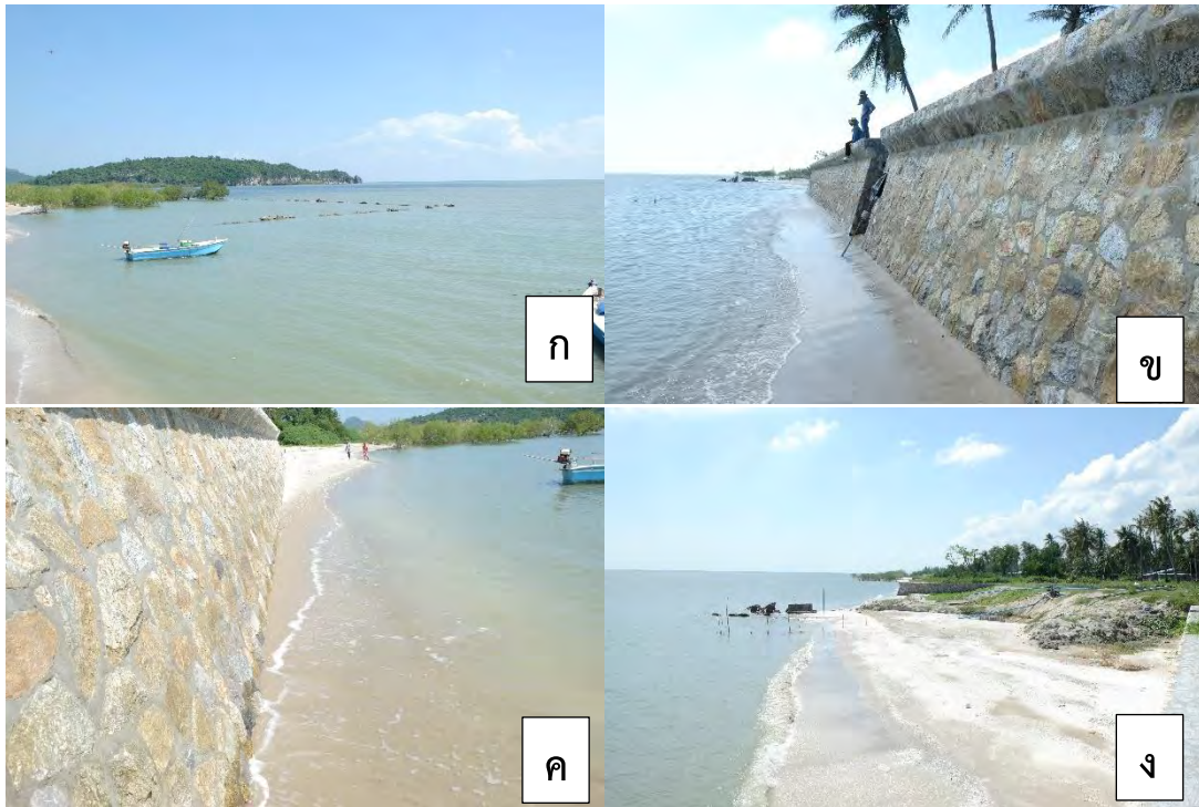
รูปที่ 4.44 ลักษณะชายฝั่งบริเวณที่มีกำแพงกันคลื่น
