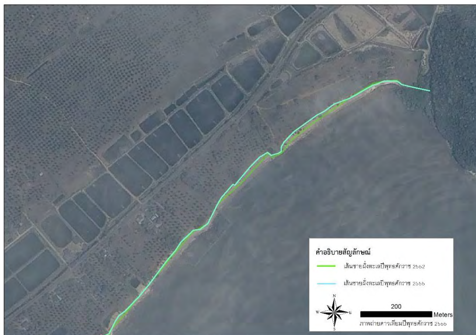
รูปที่ 4.27 การกัดเซาะบริเวณกำแพงกันคลื่นและชายฝั่งข้างเคียงช่วงปี พศ. 2552-2555
