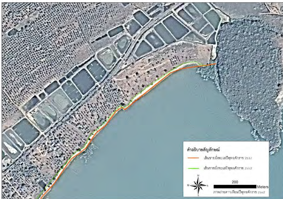
รูปที่ 4.21 การกีดเซาะบริเวณกำแพงกันคลื่นและชายฝั่งข้างเคียงช่วงปี พศ. 2537-2552
