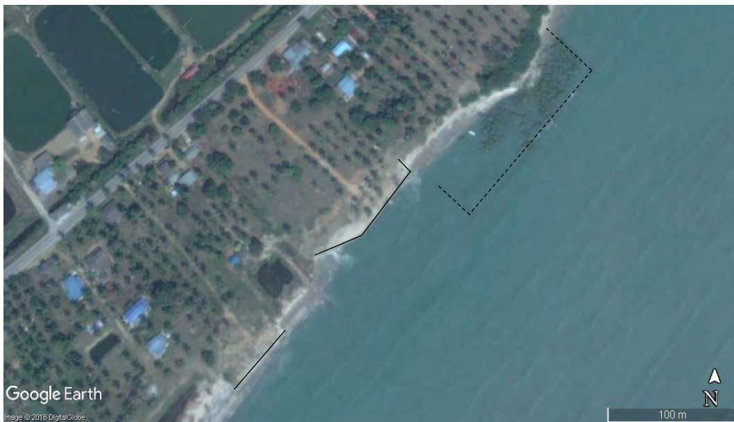
รูปที่ 4.43 ชายฝั่งทะเลบริเวณที่มีการสร้างกำแพงกันคลื่น
