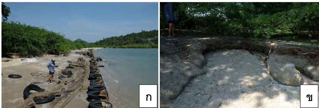
รูปที่ 4.40 กำแพงกันคลื่นบริเวณตอนเหนือของพื้นที่ศึกษา
