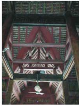
รูปภาพที่ ๔.๑๑๕ โครงสร้างหลังคาส่วนต่อกับมุขข้าง วิหารวัดพระธาตุศรีจอมทอง
