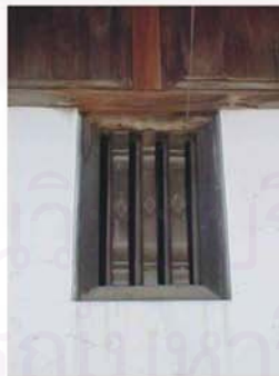
รูปภาพที่ ๔.๑๐๑ หน้าต่างไม้แบบฝาไหล วิหารวัดอินทราวาส(วัดต้นแก้ว)
