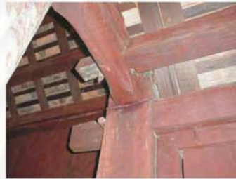
รูปภาพที่ ๔.๘๑ การเข้าไม้ส่วนโครงสร้างหลังคา วิหารวัดทุ่งอ้อหลวง
