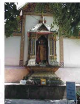
รูปภาพที่ ๔.๕๔ ชும்จระนำประดิษฐานพระยี่น ผนังด้านหลัง วิหารวัดศรีเกิด
