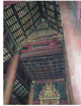
รูปภาพที่ ๔.๑๐๔ โครงสร้างหลังคา และการทำฝ้าเพดาน วิหารวัดอินทราวาส(วัดต้นแก้ว)
