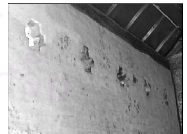
รูปภาพที่ ๕.๑๒ การเจาะช่องผนังเป็นรูปกากบาท
