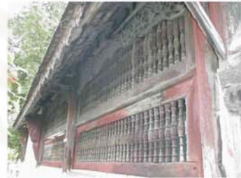
รูปภาพที่ ๔.๑๖ ผนังซีกรงไม้วิหารวัดบุพพาราม
