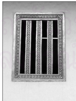
รูปภาพที่ ๕.๑๐ ลูกกรงไม้ติดด้านนอกหน้าต่าง
