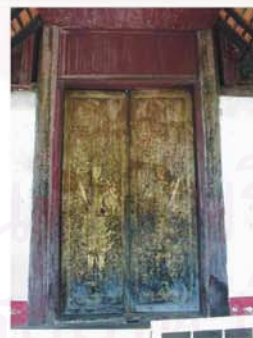
รูปภาพที่ ๔.๖๕ ประตูทางเข้าด้านหน้า ลงรักบิตทอง(ลายคำ) ภาพทวารบาล วิหารวัดสำเภา
