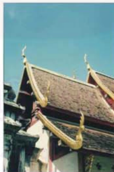
รูปภาพที่ ๔.๔๗ เครื่องปิดเครื่องมุง วิหารลายคำ วัดพระสิงห์
