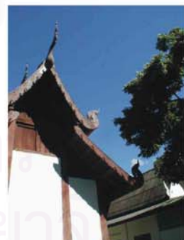
รูปภาพที่ ๔.๘๔ เครื่องปิดเครื่องมุง วิหารวัดทุ่งอ้อหลวง
