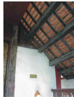
รูปภาพที่ ๔.๗๐ โครงสร้างหลังคาส່วนห้องมุขทางเข้า วิหารวัดสำเภา
