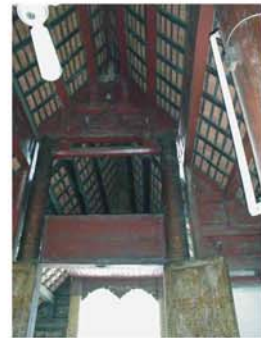
รูปภาพที่ ๔.๖๘ โครงสร้างหลังคา ภายใน วิหารวัดสำเภา
