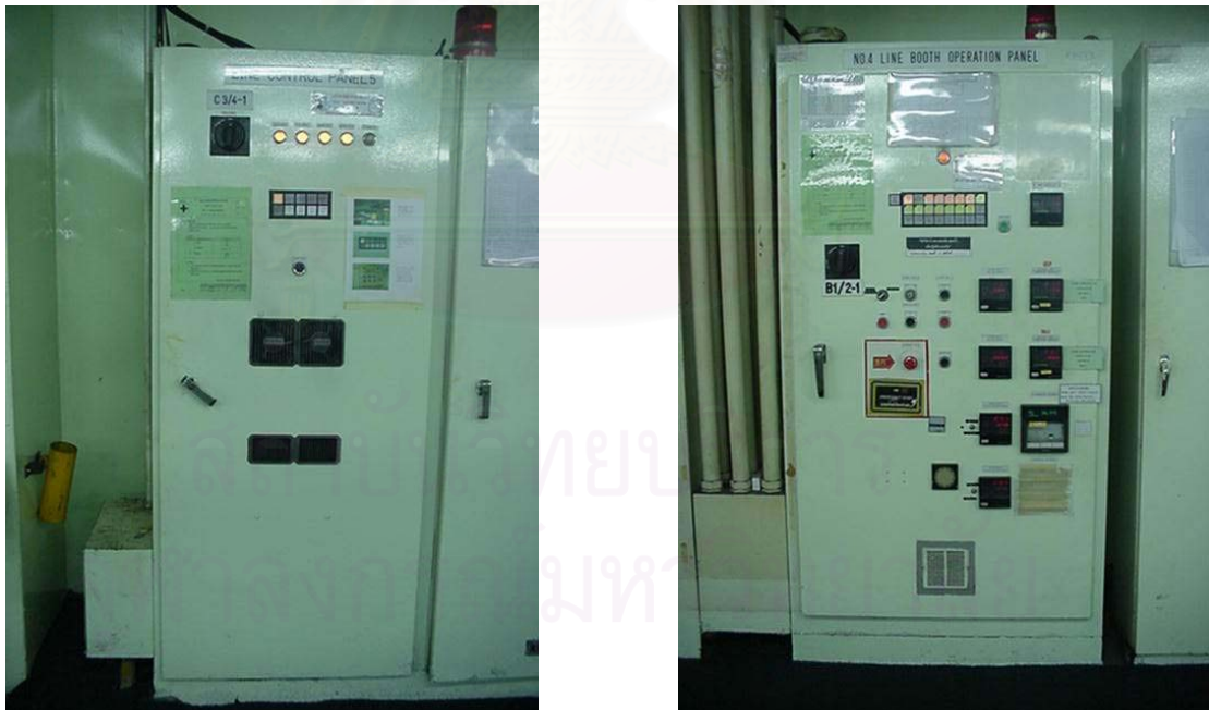
รูปที่ 5.13 ตู้ควบคุม PLC และ กระบวนการปรับอากาศ
