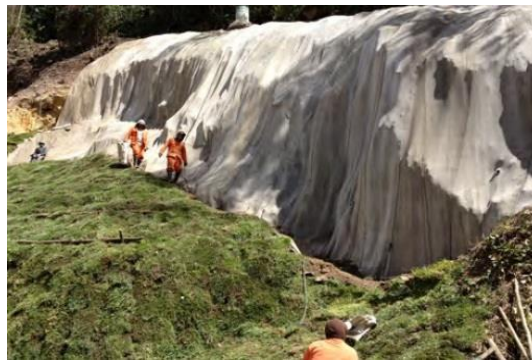
รูปที่ 2.37 เมื่อติดตั้งแผ่น GCCM เสร็จในงานเสริมเสถียรภาพของดิน [20]
