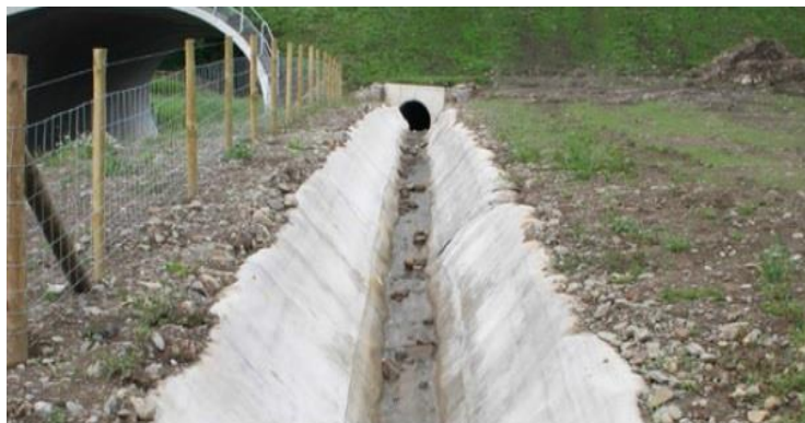
รูปที่ 2.34 ลักษณะคูน้ำที่มีการเชื่อมต่อโดยใช้ซีเมนต์ปิดรอยต่อ [20]
