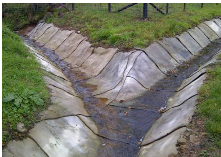
รูปที่ 2.35 ลักษณะคูน้ำที่มีการเชื่อมต่อโดยใช้การซ้อนทับของแผ่น GCCM[20]
