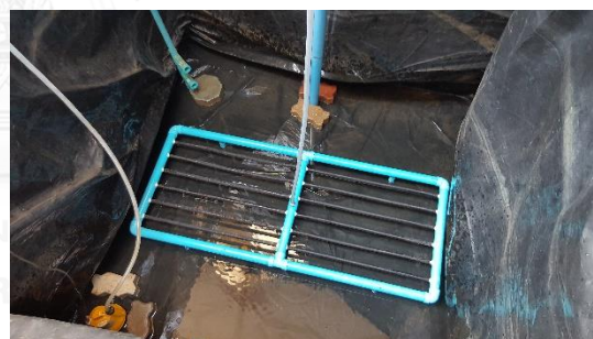
รูปที่ 3-4 หัวกระจายอากาศแบบท่อยาง (Rubber diffuser)
