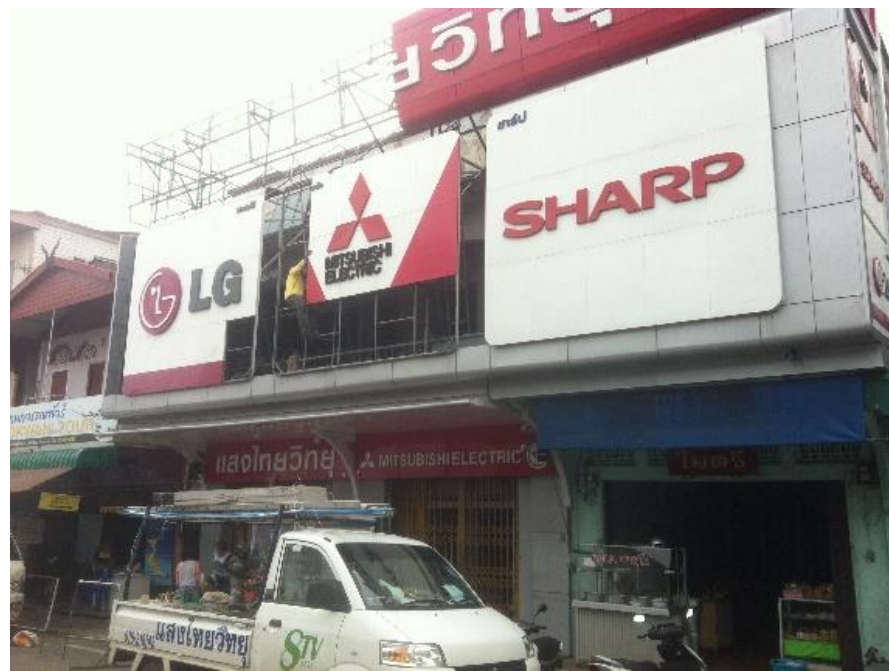
ภาพที่ 68 การต่อเติมโครงสร้างภายนอกตึกแถวโรงแรมไมตรีเฮ้าส์ในสมัยเป็นร้านเครื่องใช้ไฟฟ้า
