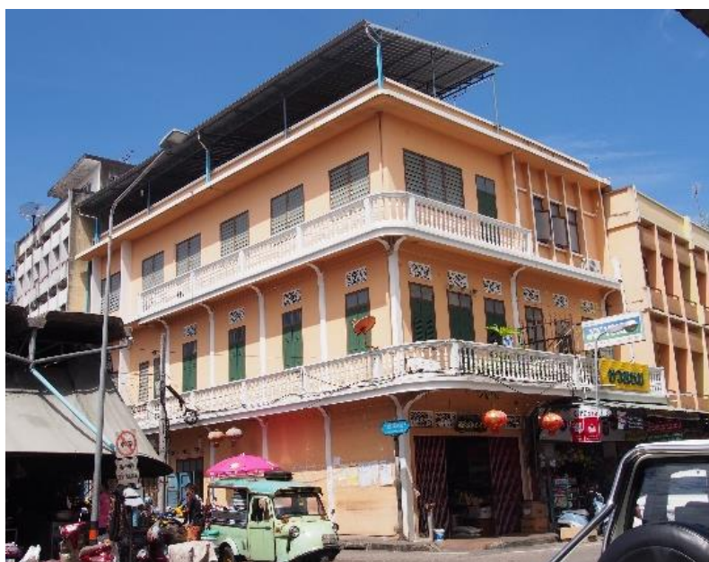
ภาพที่ 37 รูปแบบตึกแถวแบบตะวันตกรูปแบบร่วมสมัย
