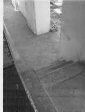
ภาพที่ 2.11 บันไดชั้นบนแทรกอยู่ ระหว่างฐานชั้นบนและเสาระเบียง
