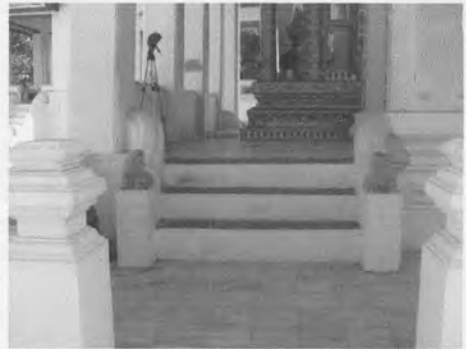
ภาพที่ 2.55 บันไดทางขึ้นเฉลี่ยและฐานรับตัวห้อง
