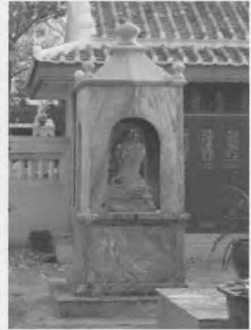
ภาพที่ 2.24 ซุ้มเสมา หลังคาทรงอย่างเก็งจิน ผิวลาดโค้งเรียบ
