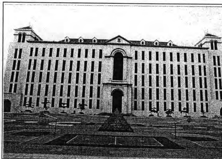
ภาพที่ 3.2 อาคารควีน ออฟ ซีบา (Queen of Sheba Hall)
