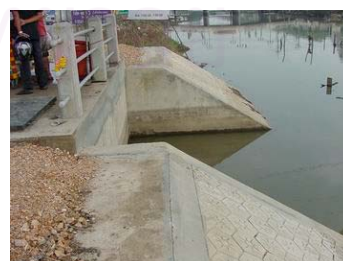
รูปที่ 3.9 อาคารควบคุมทางระบายน้ำ
